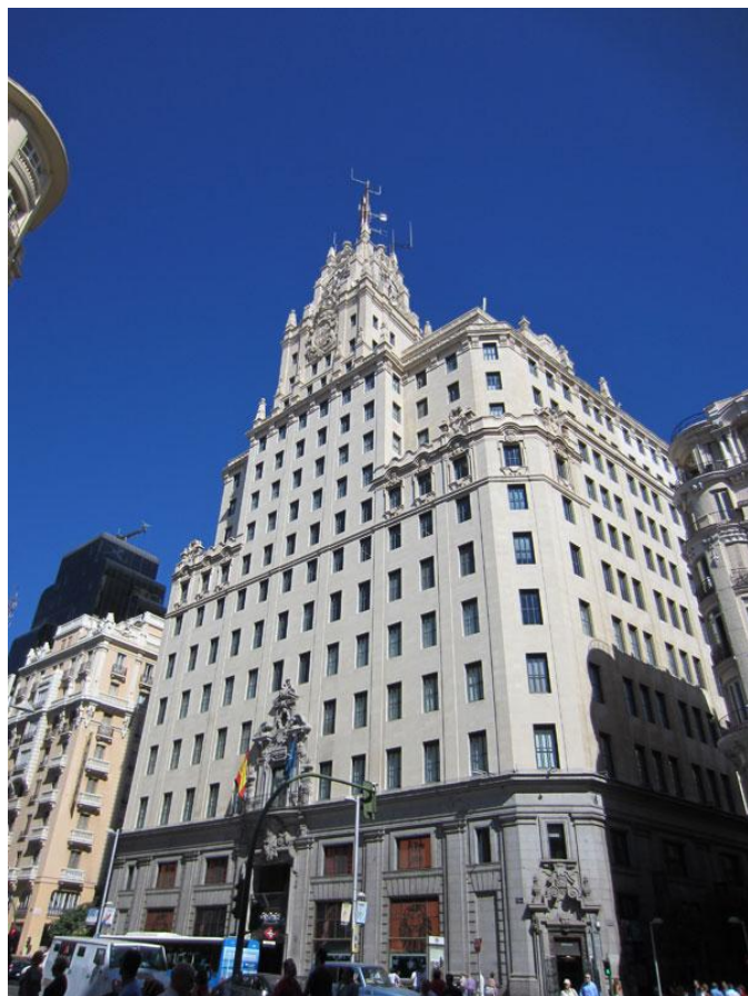
El edificio de la Telefónica, en la Gran Vía a la altura de la Red de San Luis
