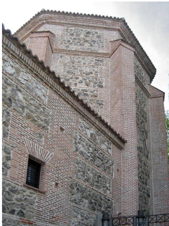
Foto 17: Vista del ábside pentagonal del templo, con la sacristía del siglo XVIII adosada a su costado sur.
