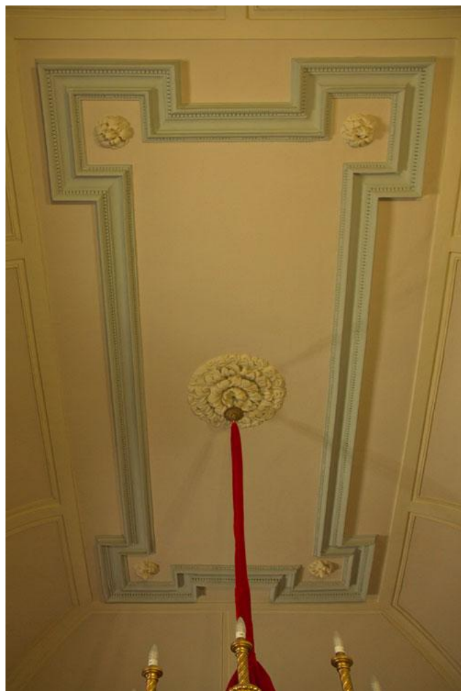
Foto 22: Bóveda dieciochesca de la Sacristía
