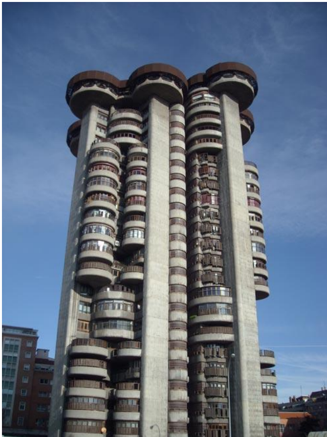
Las Torres Blancas, en la avenida de América.
