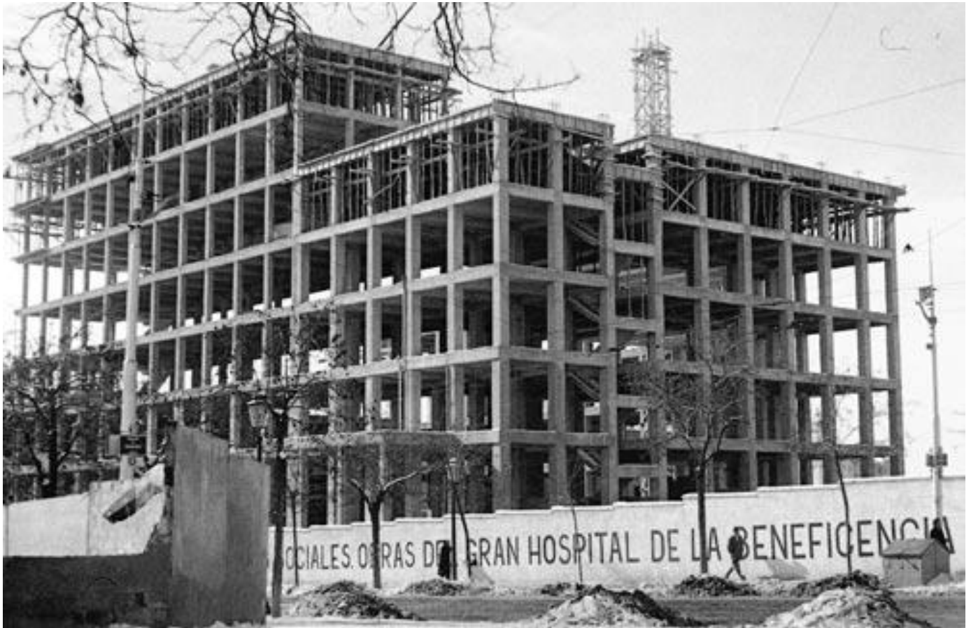
El nuevo hospital en construcción
