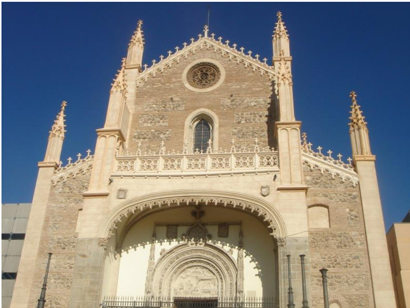
Fachada oeste de la Iglesia de Los Jerónimos. Fotografía de Paloma Torrijos.
