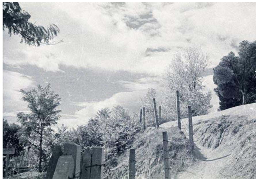
Otra vista de la alambrada del Canalillo, en este caso a su paso por la Dehesa de la Villa a la altura del Cerro de los Locos. En la esquina inferior izquierda puede apreciarse el letrero del Canal prohibiendo el paso. (Foto: J. L. Berzal, entre 1950-60)
