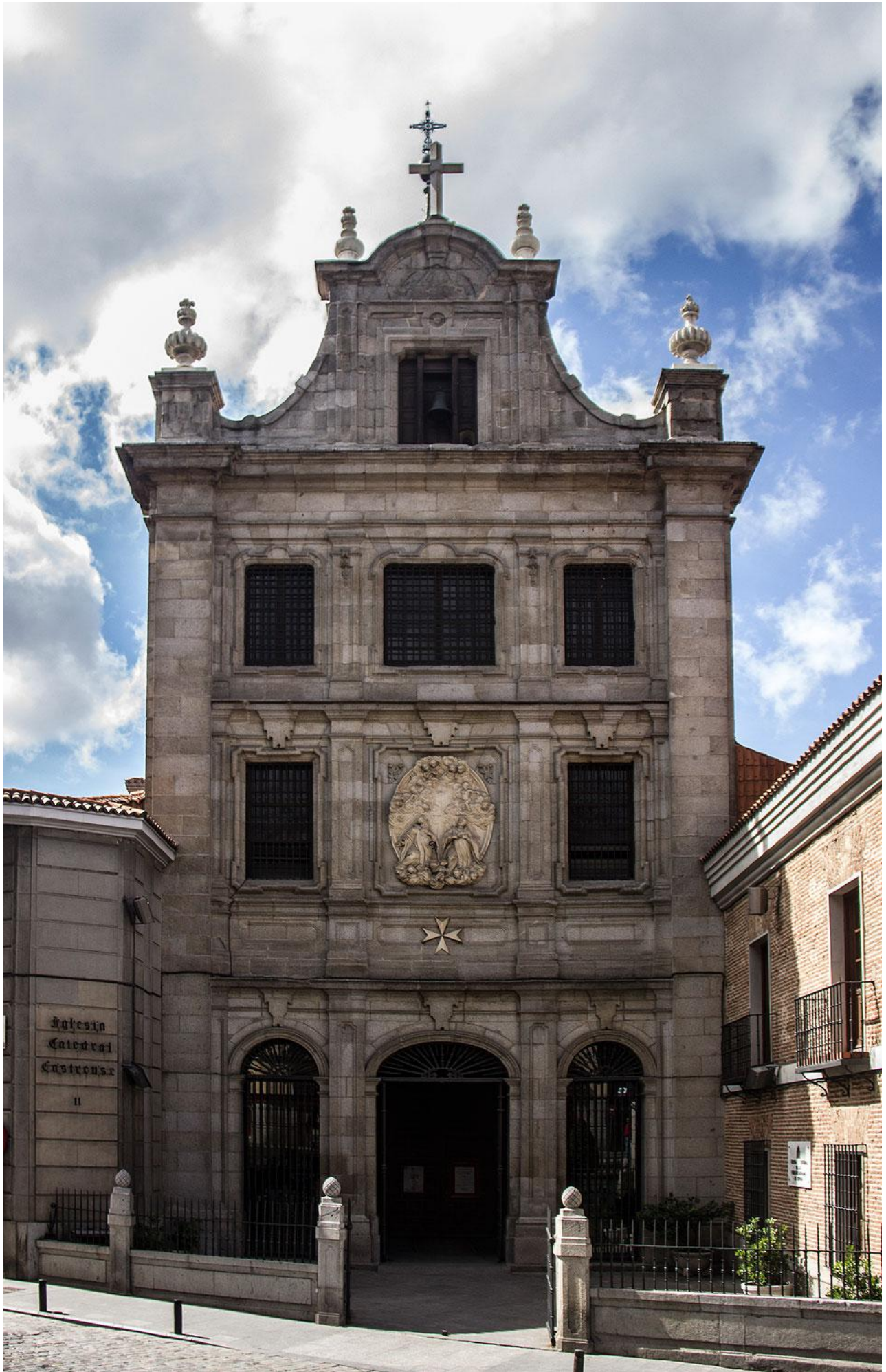
Foto 4: Vista frontal de la fachada principal del templo
