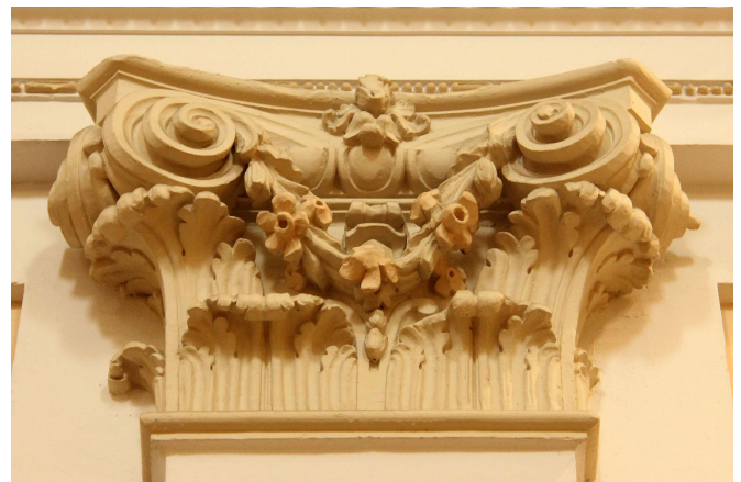
Foto 8: Vista de detalle de uno de los capiteles compuestos que otorgan gran elegancia al templo.
