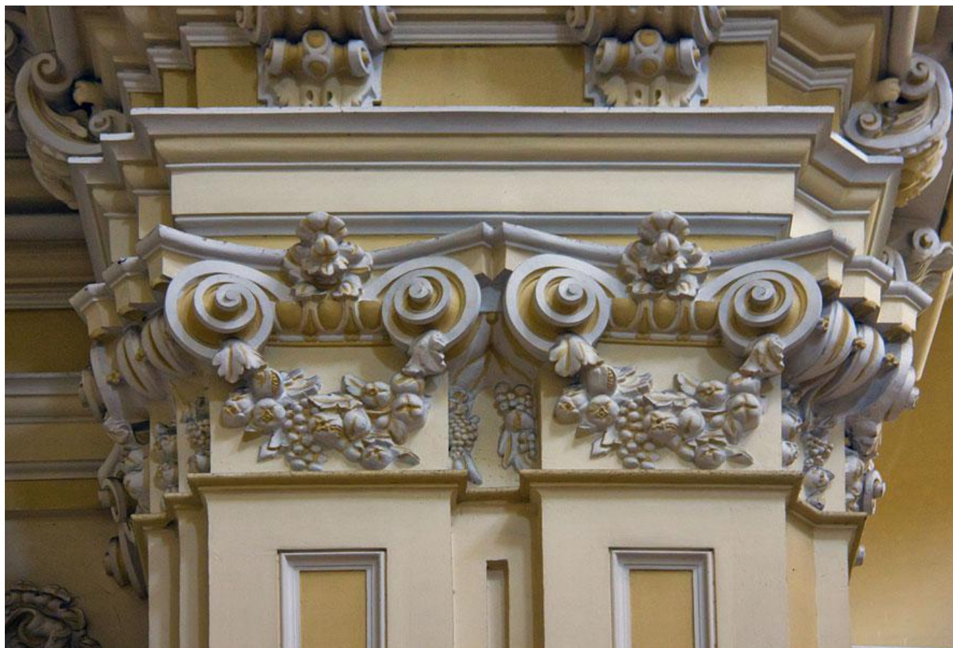
Foto 12. Vista de los capiteles jónicos que rematan las pilastras cajeadas del templo.
