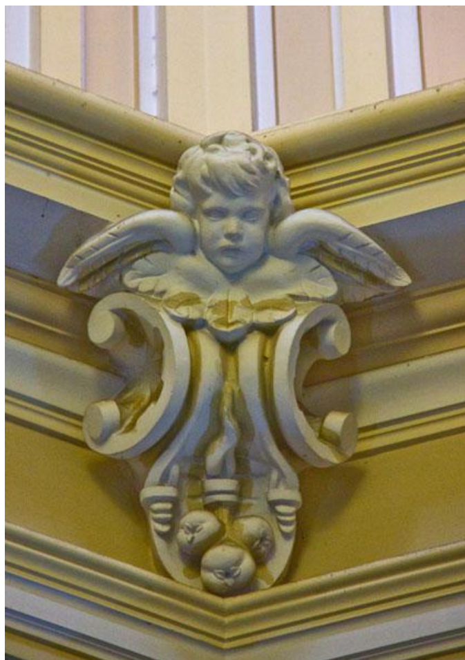
Foto 11. Detalle de uno de los querubines que ornamentan las cornisas de las cúpulas menores.
