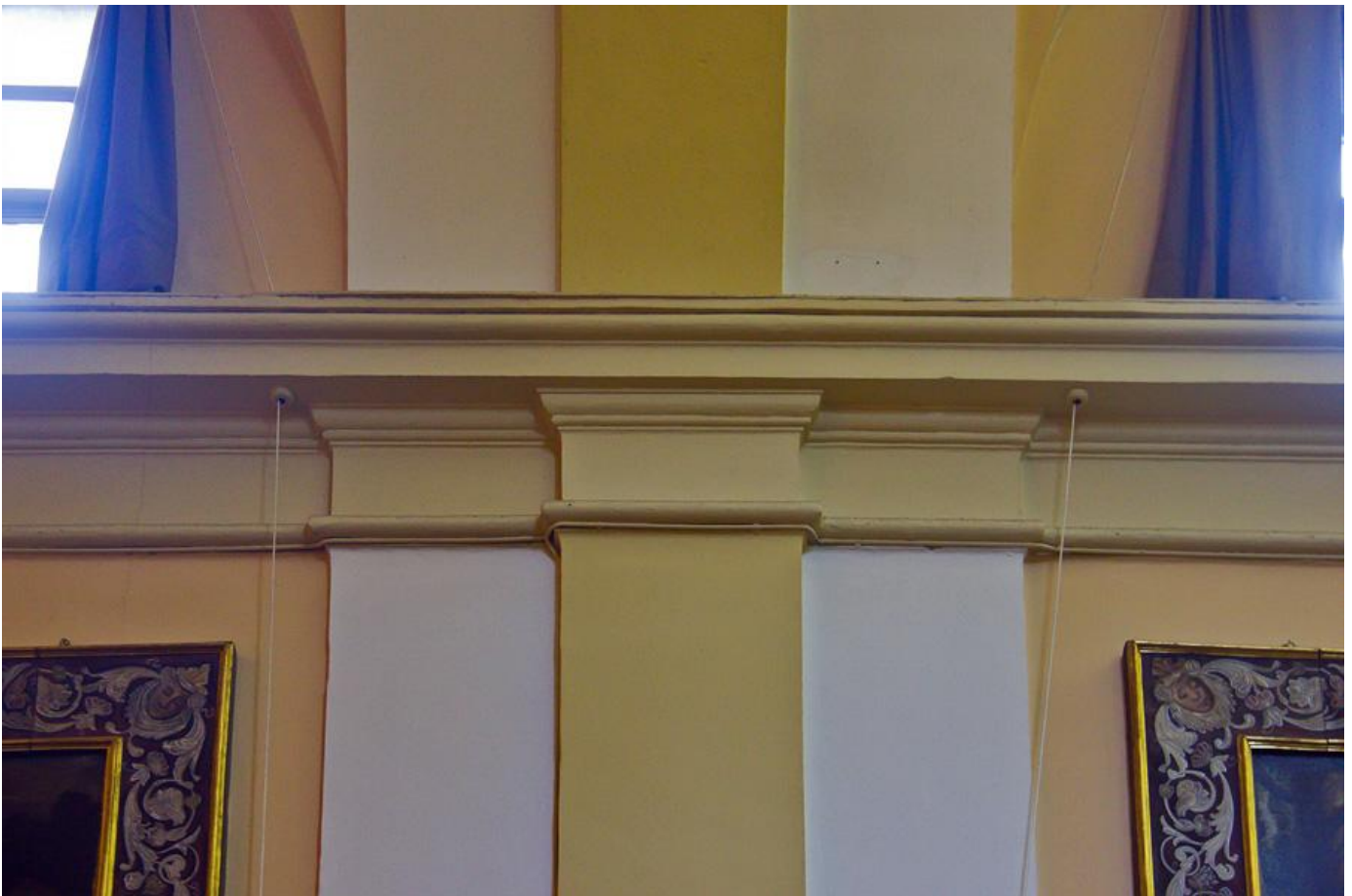
Foto 6. Pilastras toscanas de la nave de la iglesia.
