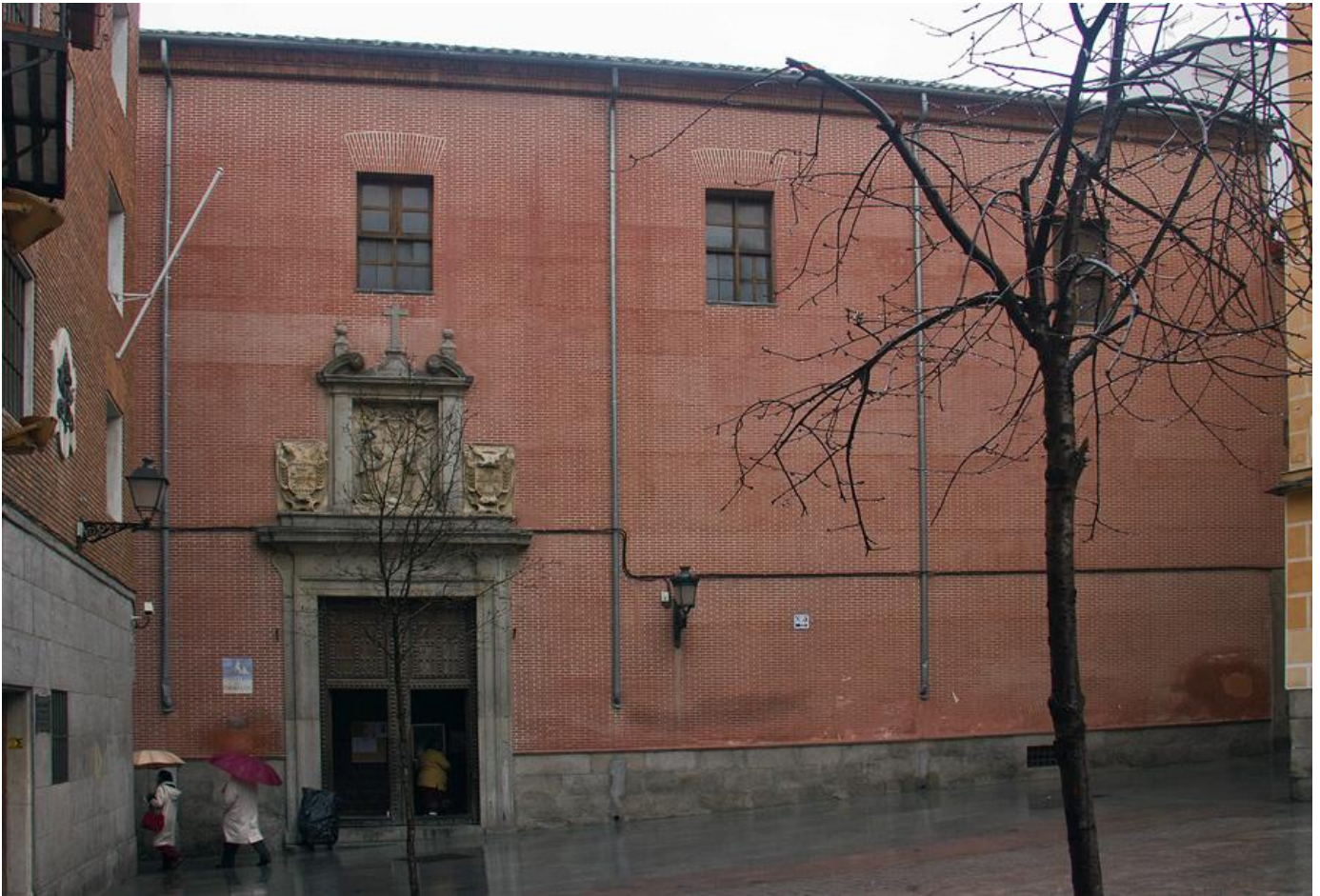
Foto2. Vista general de la fachada principal del templo conventual. Siglo XVII.
