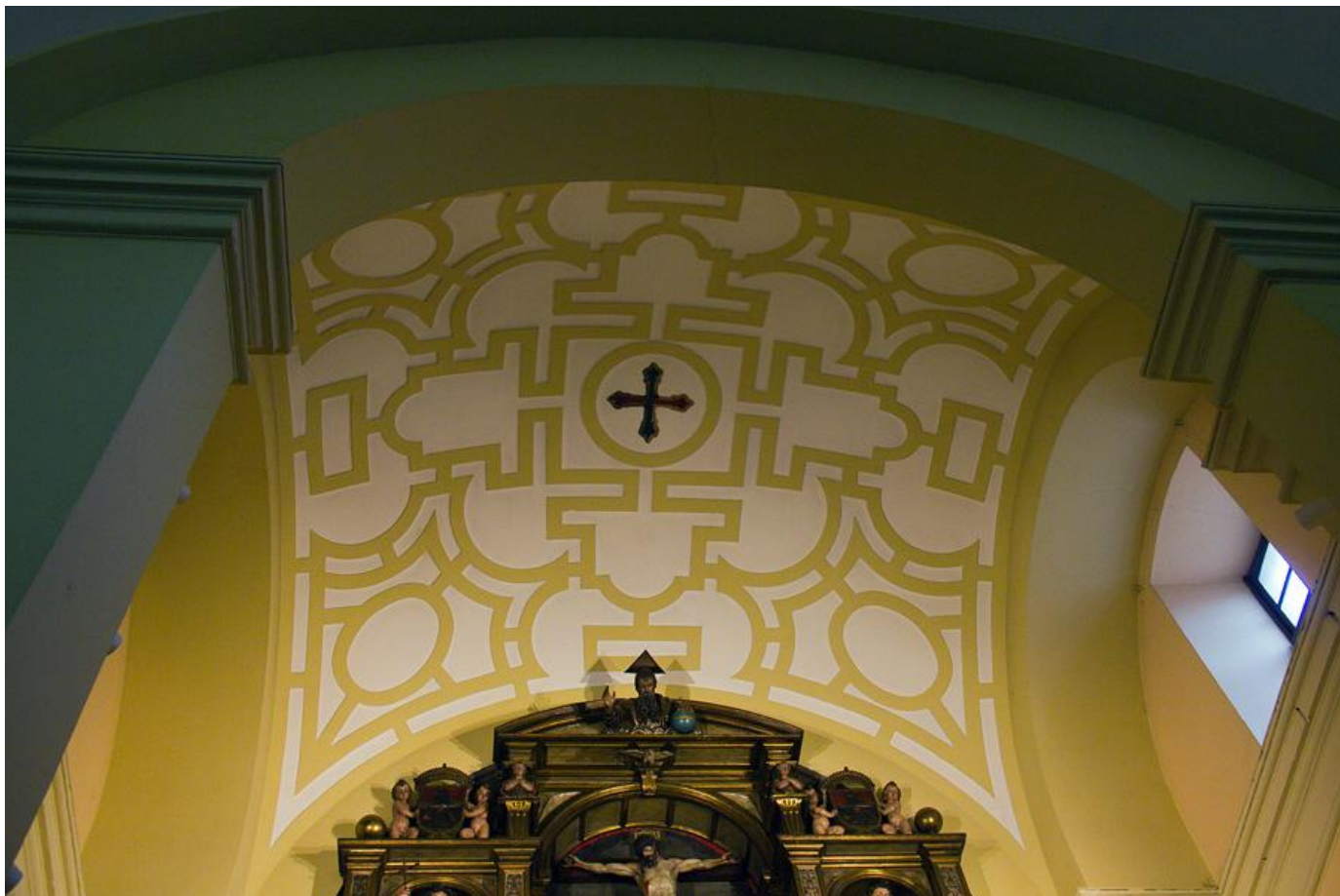
Foto 7. Bóveda vaída del presbiterio, decorada con yeserías geométricas.
