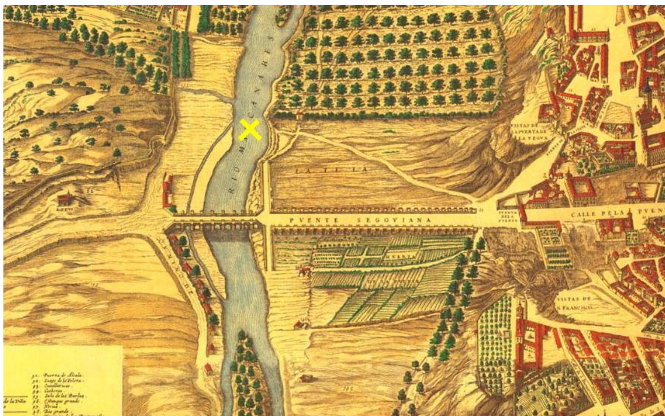
Puente de Segovia, una de las principales obras públicas realizadas en el Madrid de aquellos años, según versión coloreada del plano de Texeira. Señalado con una X amarilla, el emplazamiento del puente medieval al que sustituyó, delatado por el camino que aparece en la orilla oriental, ya sin utilidad. El nuevo de Juan de Herrera permitía el paso de un carril para los carros de entrada y otro para los de salida, y tras la guerra civil de 1936-1939 fue ensanchado a sus dimensiones actuales.
