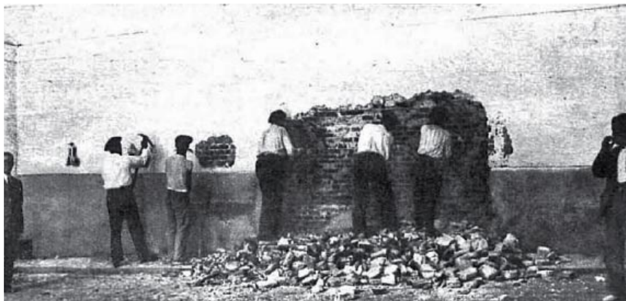
Comienzo de las obras de derribo
