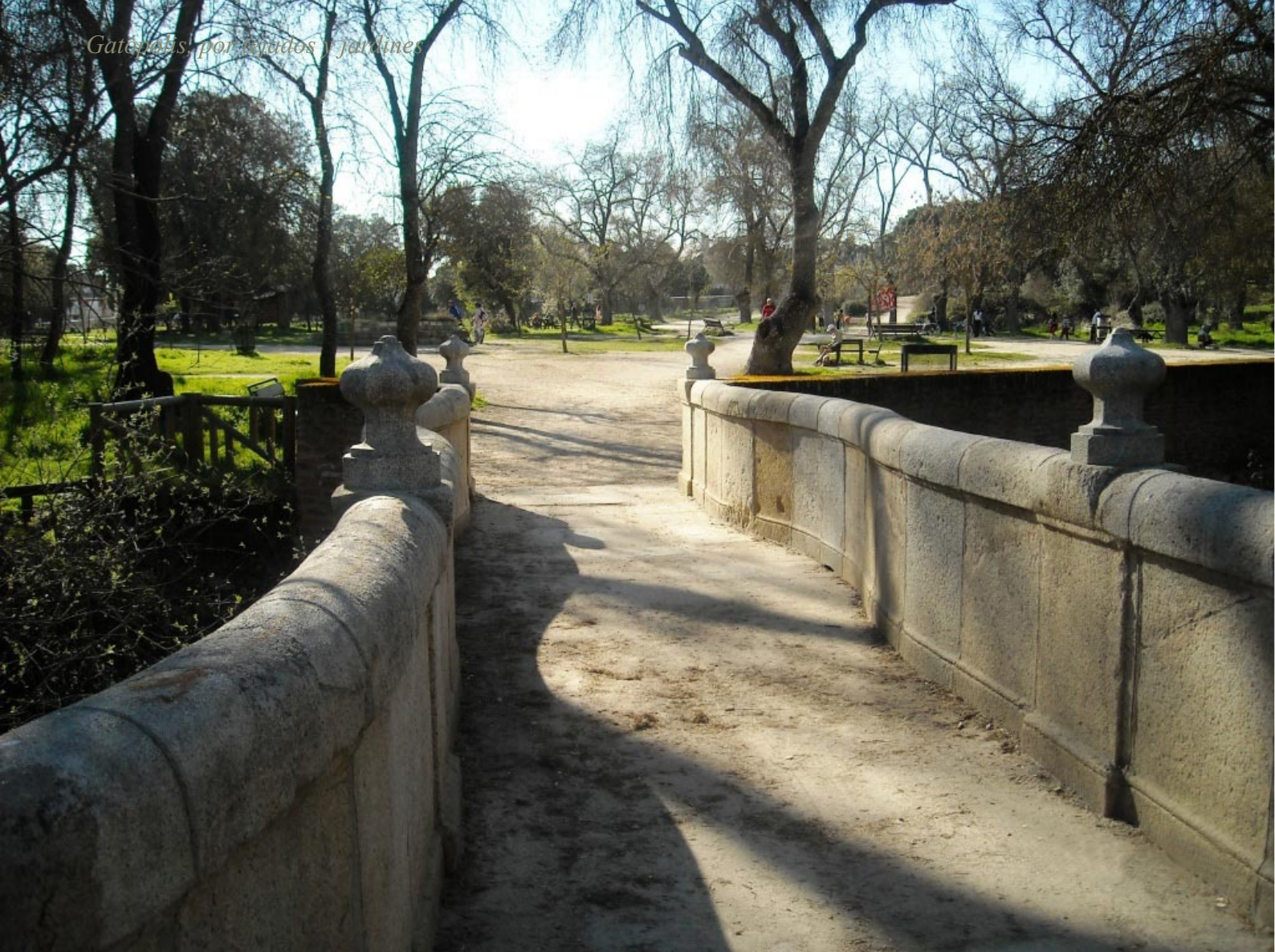
Detalle del Puente de la Culebra
