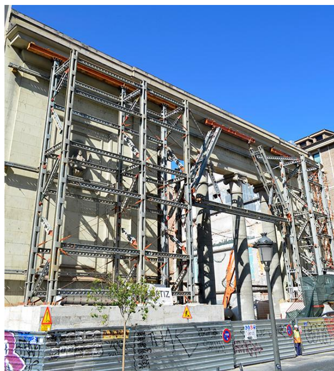
Foto 5. Fachada principal del cine Madrid, apeada tras su vaciado interior.
