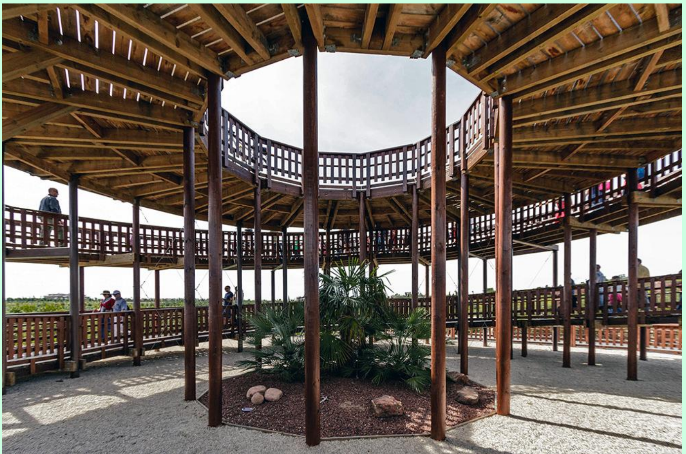
El mirador consiste en una rampa circular por la que se accede al piso superior. En el centro, una palmera que, con los años, superará la altura de la estructura que la rodea.
