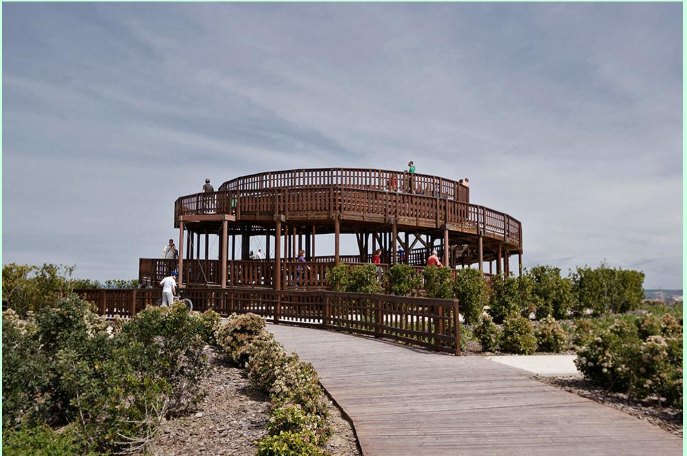
Vista del mirador del Parque, construido en madera.
