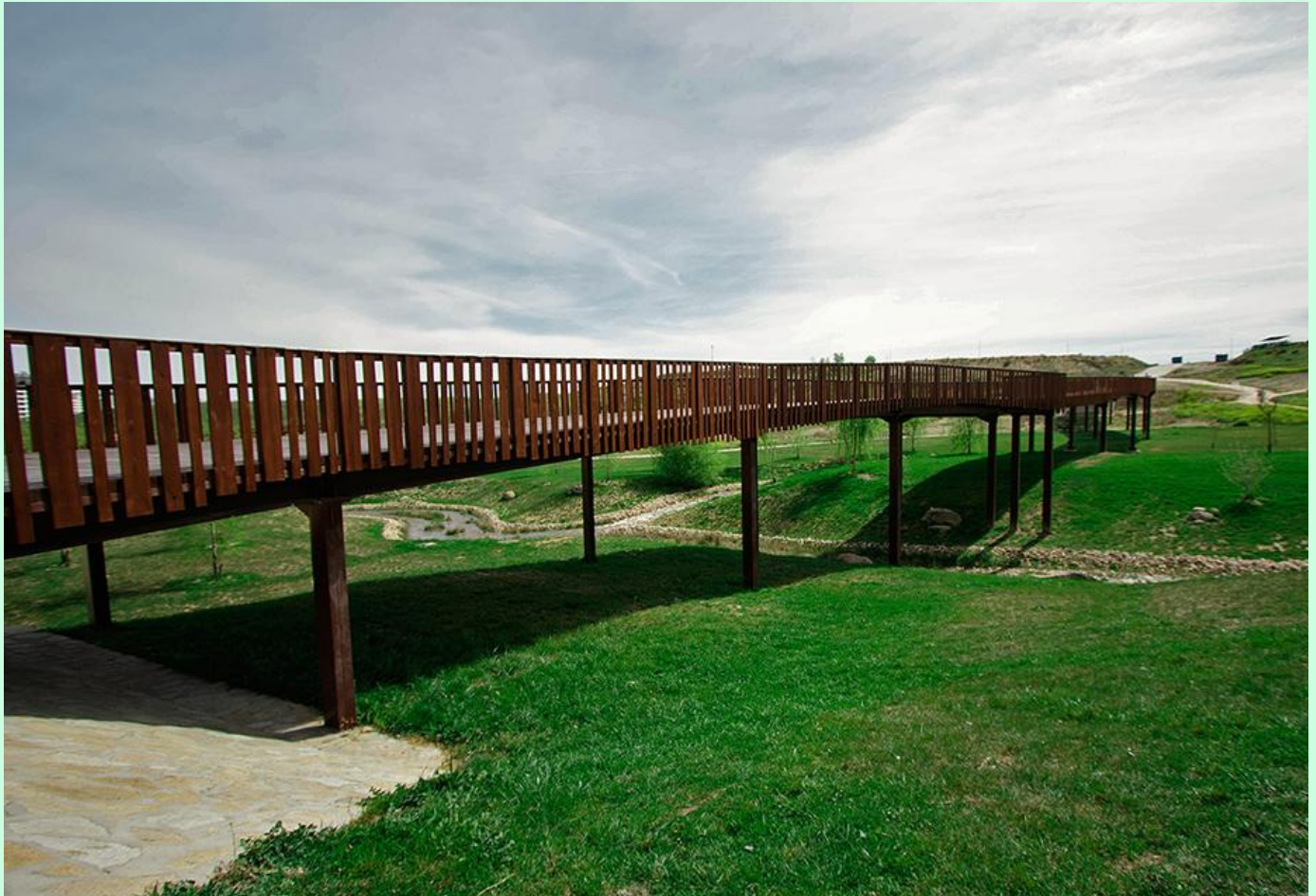
Dos espectaculares pasarelas permiten cruzar el cauce del arroyo.
