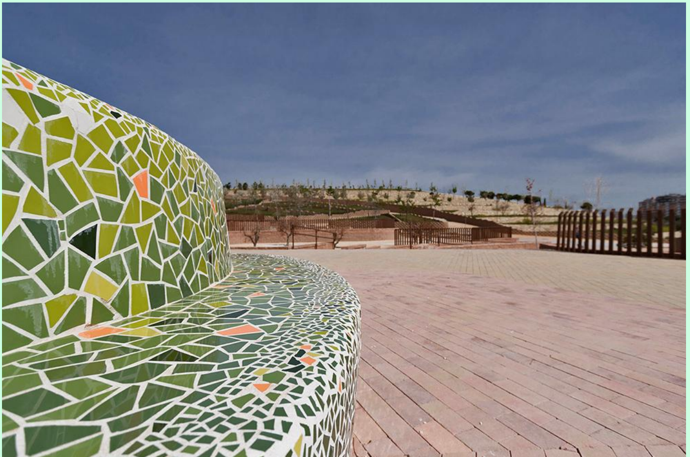
Los bancos están revestidos de cerámica, siguiendo la técnica del trencadís, clara alusión al estilo modernista catalán.
