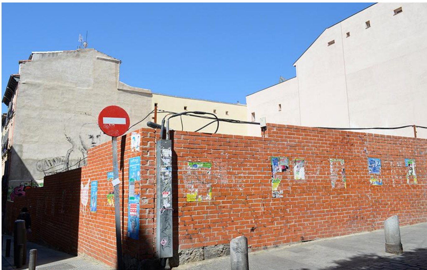
Foto 7. Solar y tapias resultantes, tras el derribo de la casona solariega en 2013.
