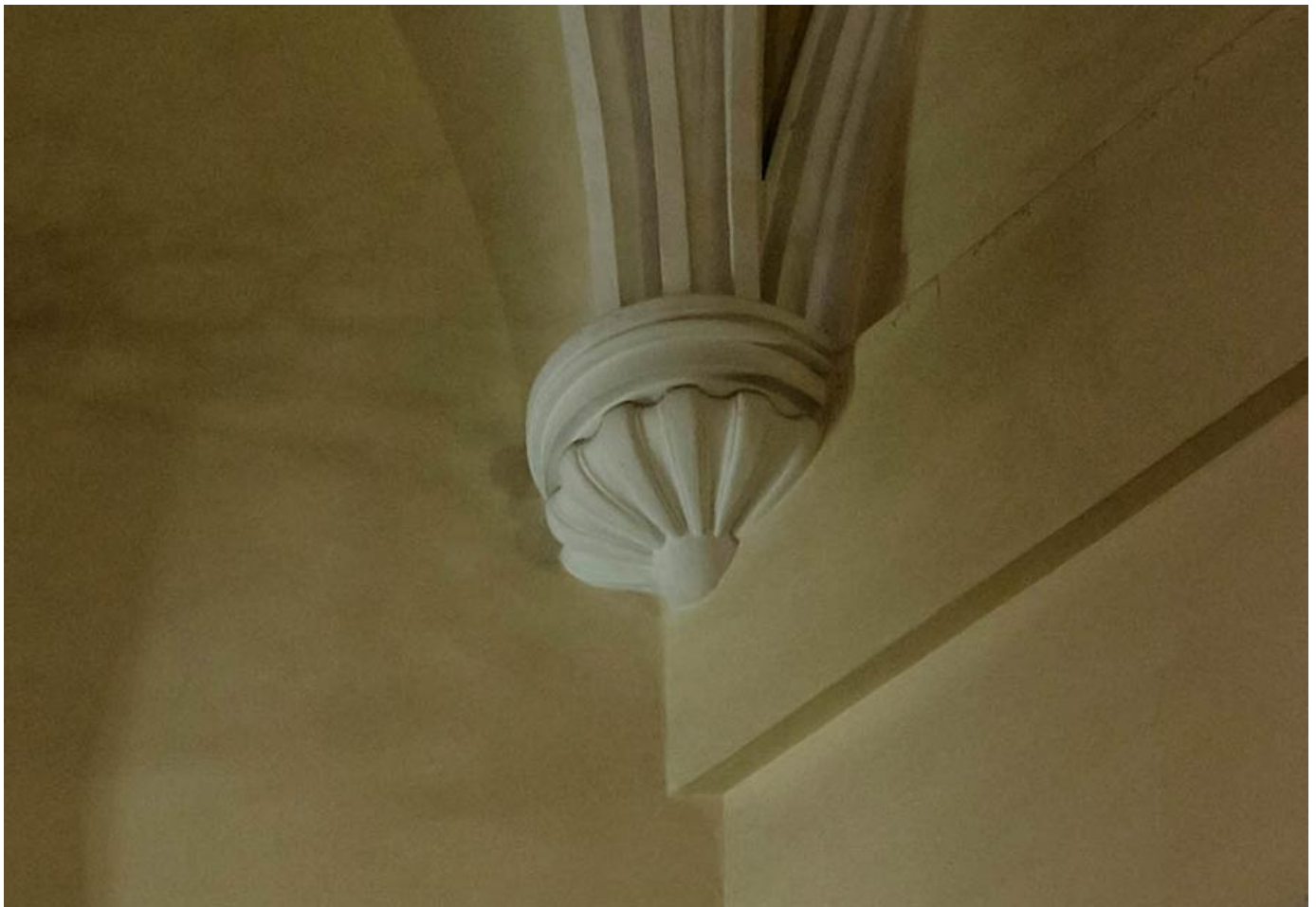
Foto 1. Ménsula con "gallones" o gallonada, existente en el presbiterio de la iglesia.
