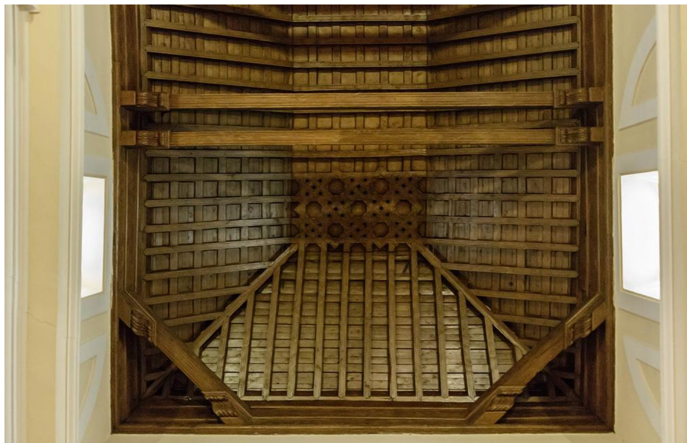
Foto 5. Vista del sector oriental de la armadura mudéjar “de par y nudillo”, que cubre la nave central. Siglo XVI.
