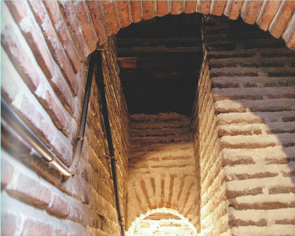
Foto 7. Arquillo de refuerzo y apoyo de las tablas de los escalones, en el interior de la torre. (Fuente: "ENCICLOPEDIA DEL ROMÁNICO EN MADRID. Iglesia de San Nicolás de los Servitas. Aguilar de Campoo. 2008).
