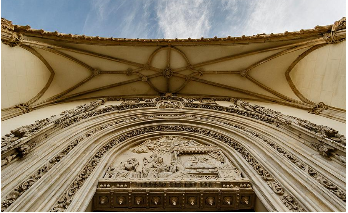
Foto 3. Vista de la bóveda de crucería del atrio sobre la portada neogótica de Ponciano Ponzano.
