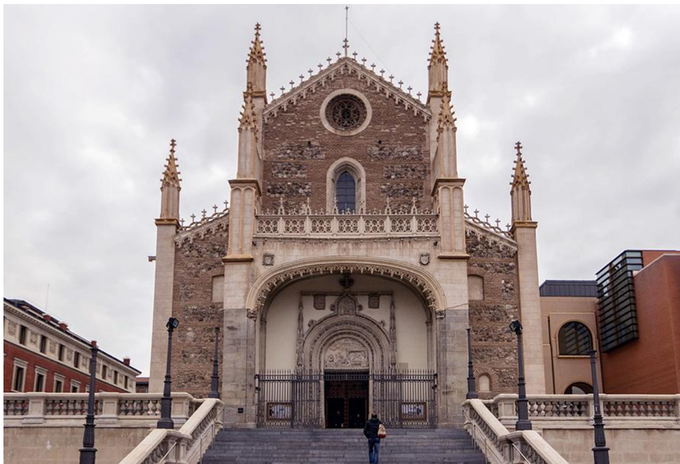
Foto 2. Fachada principal del templo sobre la escalinata construida con motivo de la boda del rey Alfonso XIII, en 1906, y recientemente restaurada.
