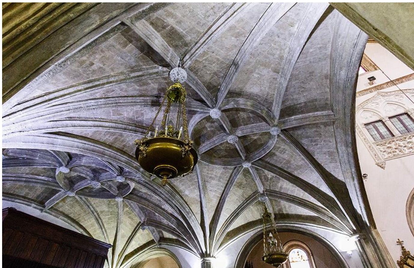
Foto 5. Bóveda de dos tramos del sotacoro, de cruería estrellada, correspondiente al gótico isabelino.
