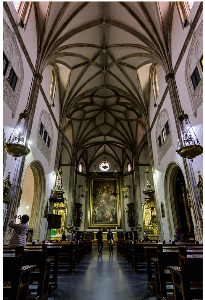
Foto 4. Vista general de la nave central del templo y de sus bóvedas de crucería góticas.
