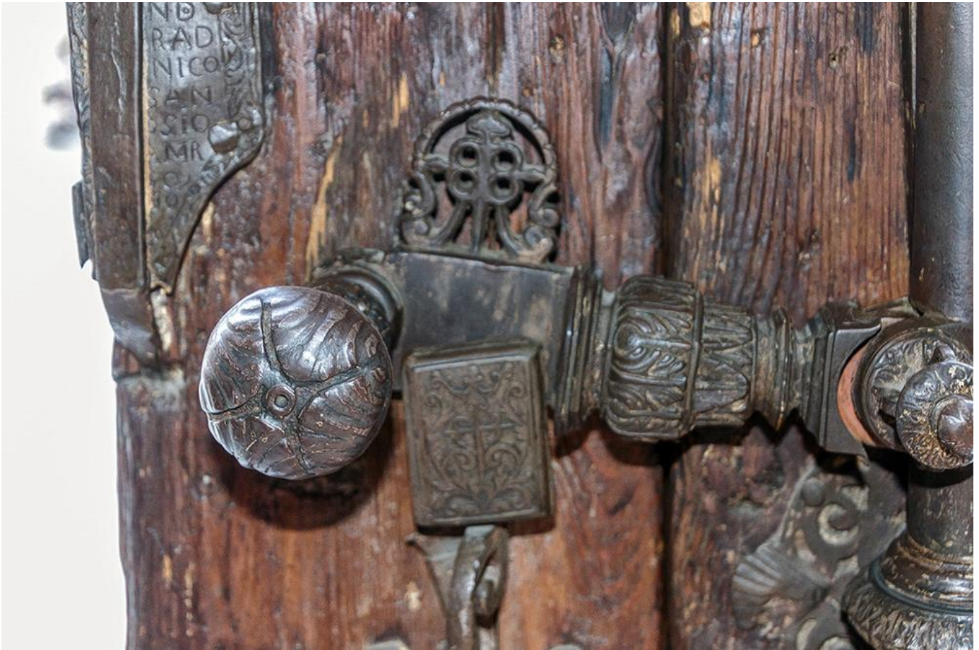
Foto 46. Cerrajería de la puerta principal de la iglesia de Santiago, con la Cruz de la Orden. ¿Siglo XVII?
