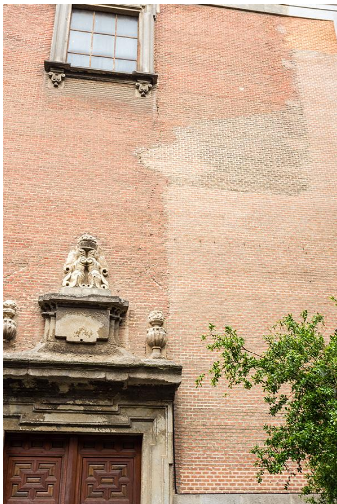
Foto 17. Huella, en la fachada oriental de la antecapilla que muestra el contorno de la nave principal de la iglesia, demolida en 1955.
