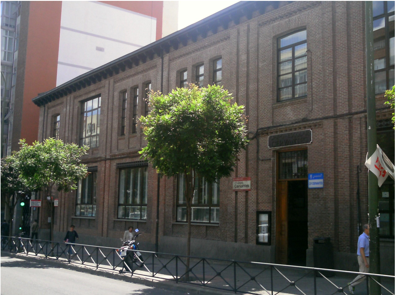
Fachada a la calle Raimundo Fernández Villaverde. La Comunidad de Madrid mantiene en esta parte del edificio la biblioteca Ruiz Egea. El Ayuntamiento, el colegio Cervantes, y además utiliza varias dependencias en la parte que da a la glorieta de Cuatro Caminos.
