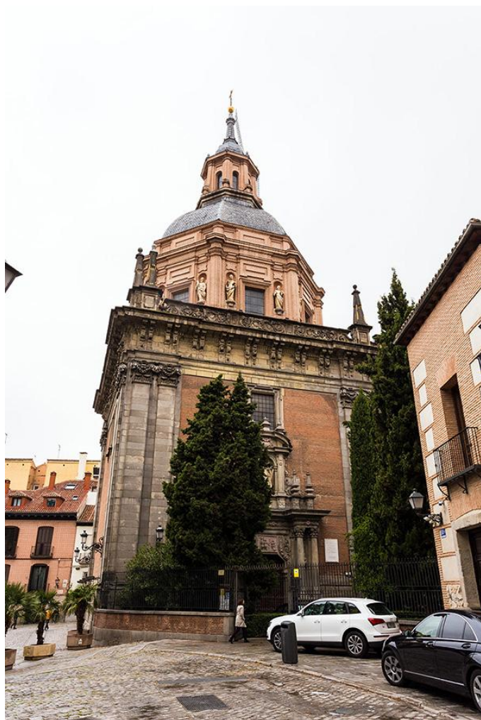
Foto 5. Vista general de la Capilla de San Isidro por su fachada oriental.
