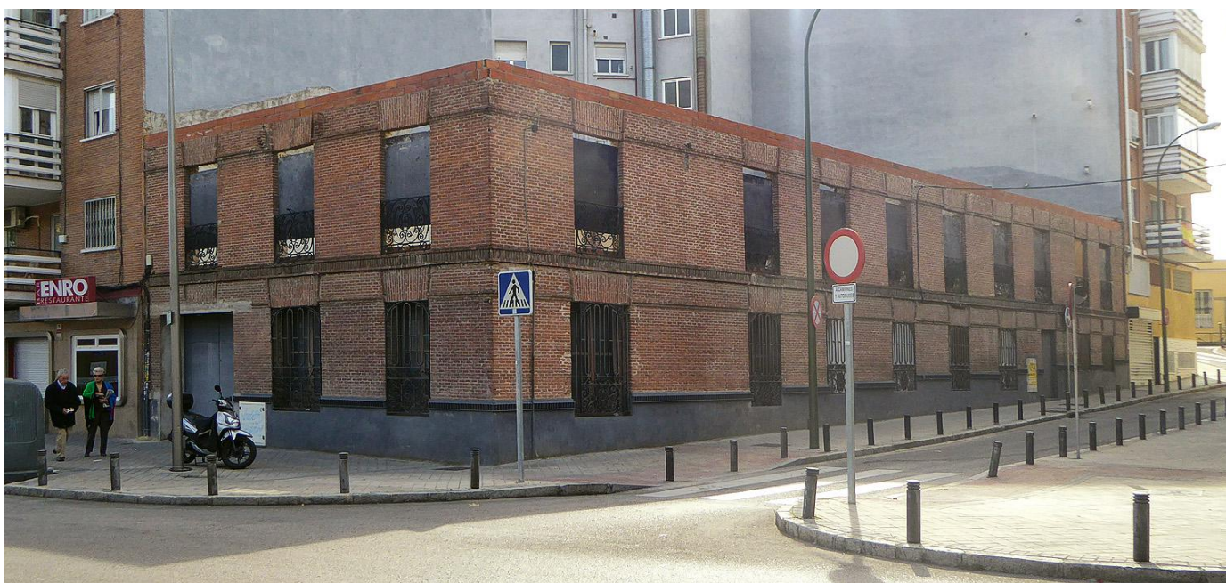
Edificio actual del edificio (año 2017) cuyo pésimo estado de conservación hace temer su pronta desaparición.
