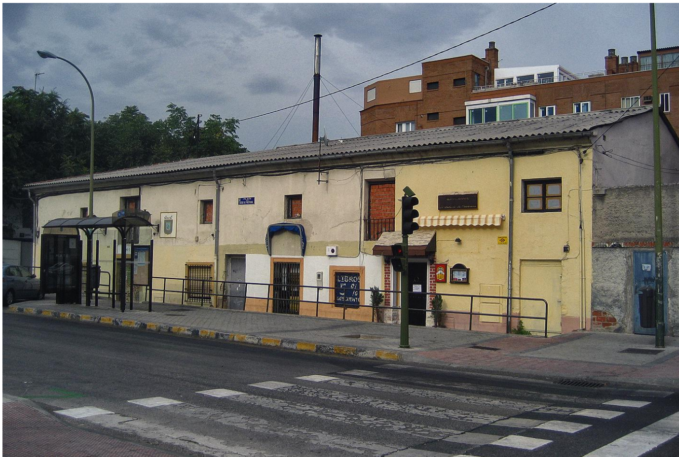
Vista del edificio derribado en la plaza del Duque de Pastrana,. Los vanos cegados con ladrillos anunciaban ya su progresivo abandono y anticipaba su próxima desaparición.
