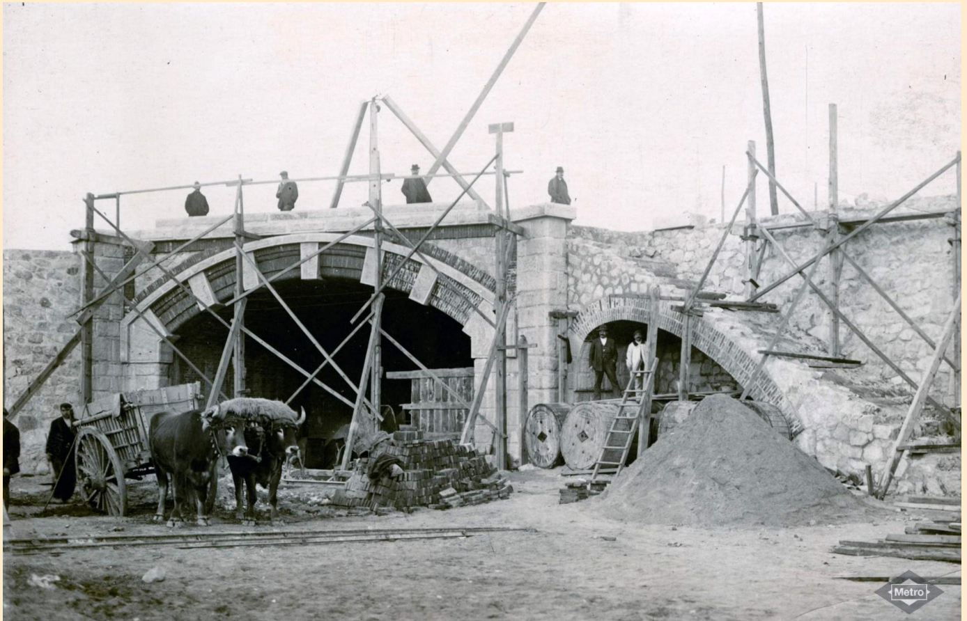
Construcción de la boquilla del túnel de las Cocheras. Fuente: Archivo Fotográfico de Metro de Madrid.
