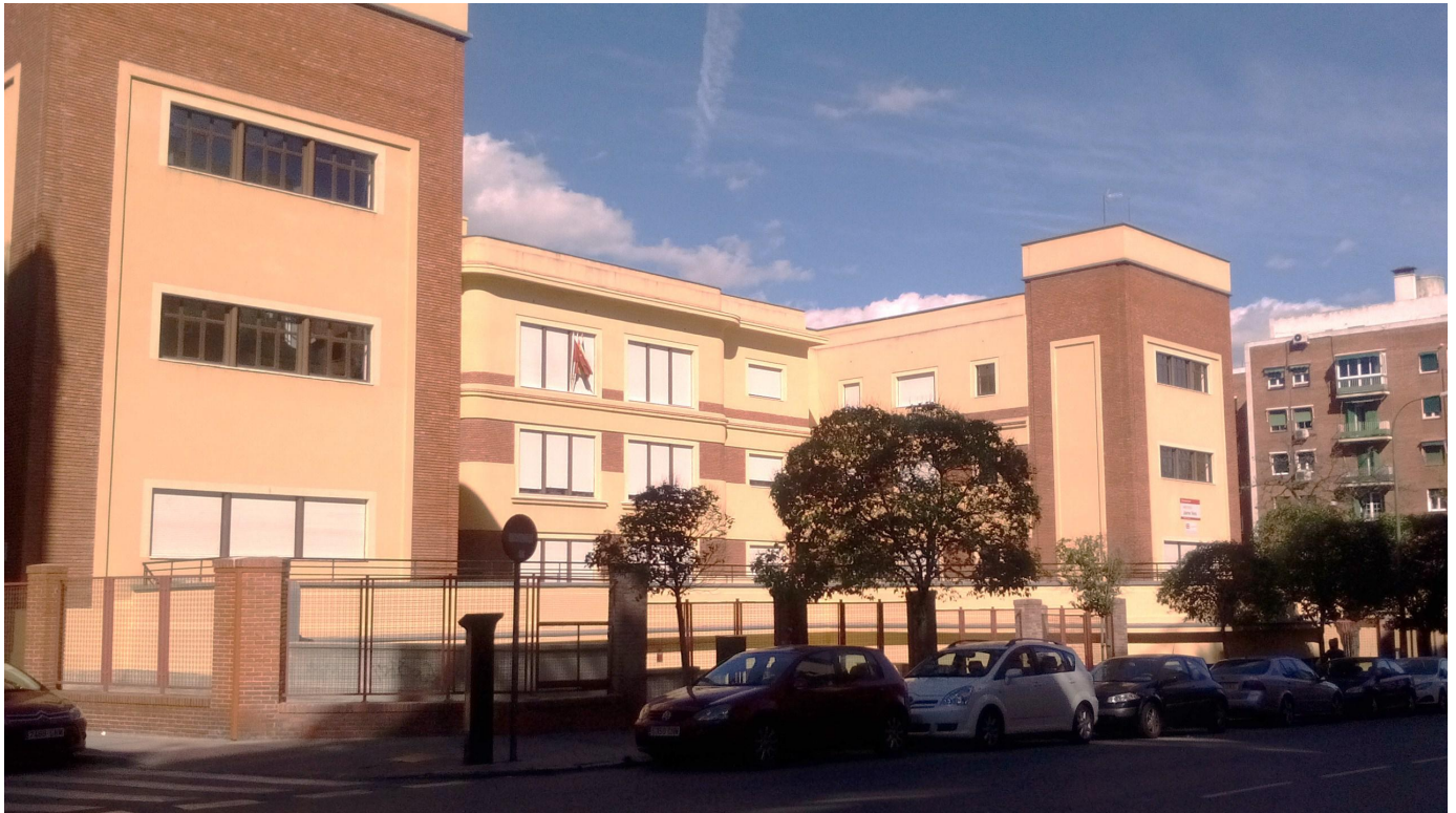
El "otro" Jaime Vera, nombre actual que se ha dado al antiguo grupo "Emilio Castelar" de la República. Este edificio mantiene la función educativa, pero para bachillerato en vez de para enseñanza primaria.
