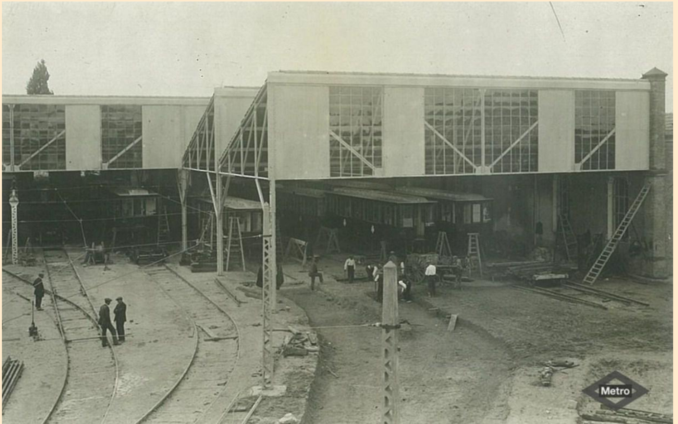
Naves A y B de las cocheras de Cuatro Caminos tras su construcción. Fuente: Archivo Fotográfico de Metro de Madrid.
