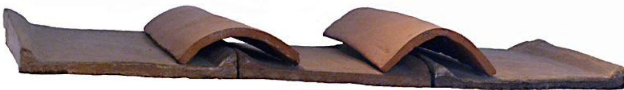
Foto 10. Disposición ideal de un tejado romano, integrado por "tegulas" (planas) e "imbrices" (curvas). (Foto: Fernando Delgado Béjar - Wikimedia Commons)
