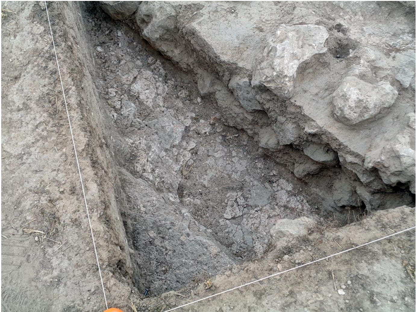
Foto 6. Detalle de la cimentación de los muros de la "domus", con restos blanquecinos de estuco desprendido.
