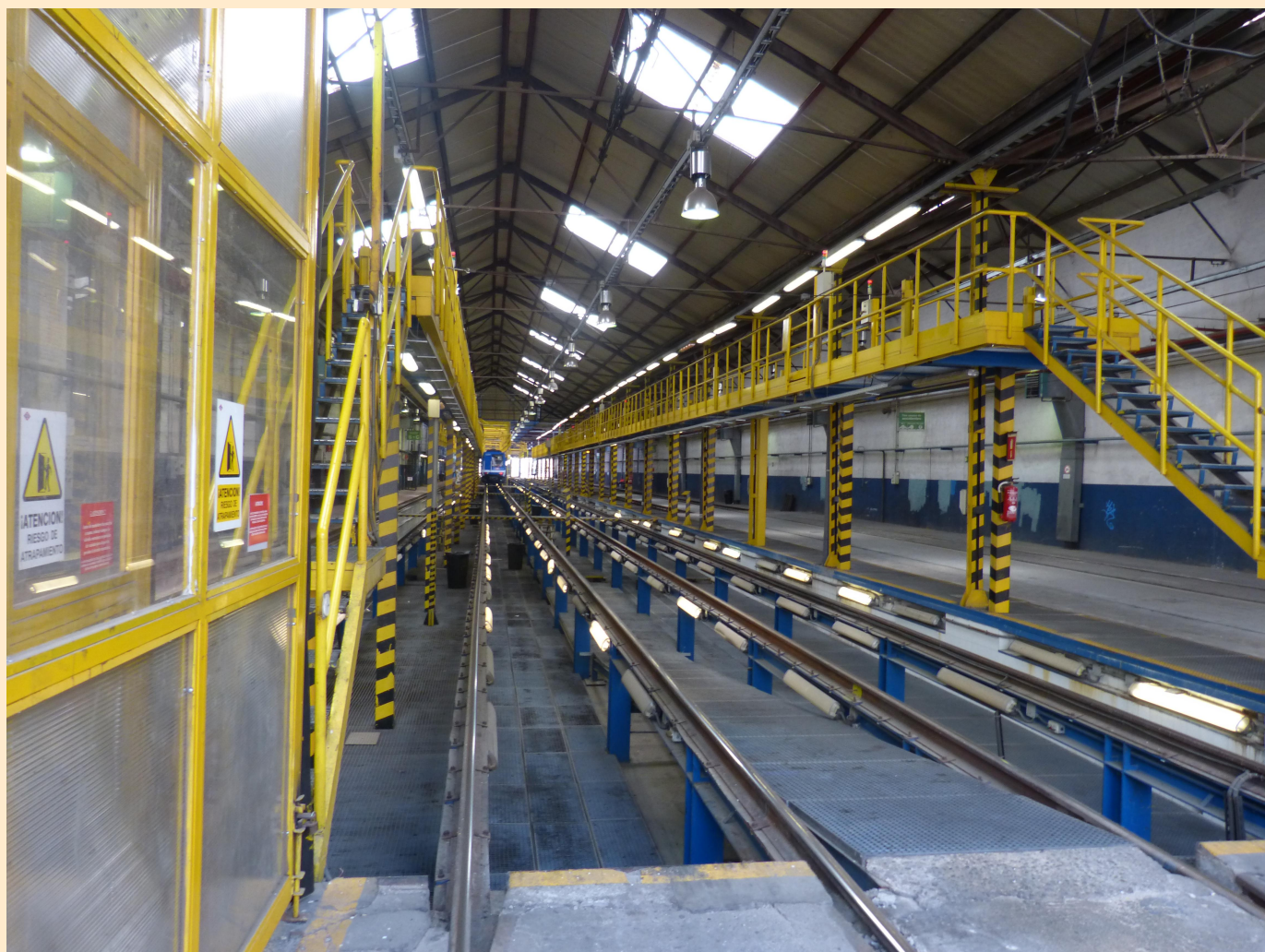
Interior de las naves D en la actualidad. Foto: autor.
