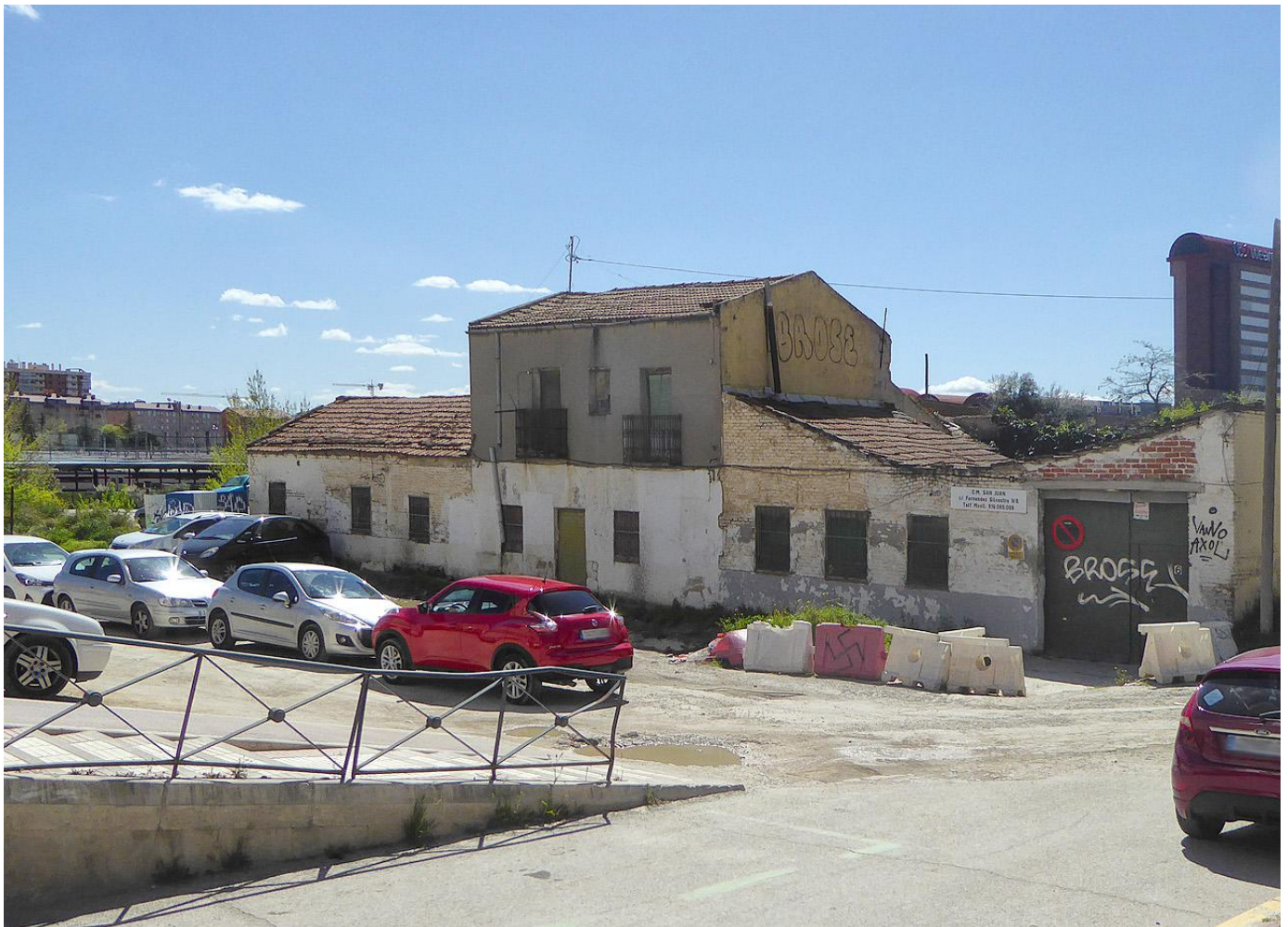
Grupo de edificios en la calle de Fernández Silvestre. Tanto su estado como la transformación de su entorno hacen prever su cercana desaparición. (Foto:autor, 2017).
