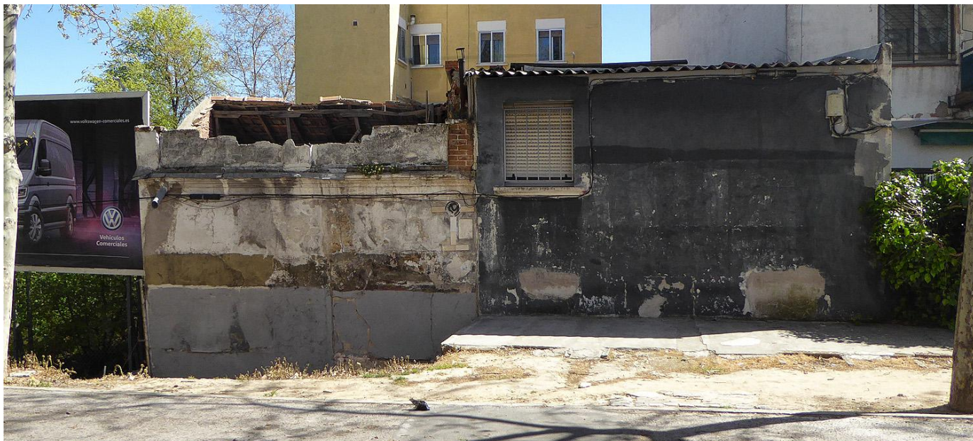
Ruinas en la calle de Manuel Ferrero.
