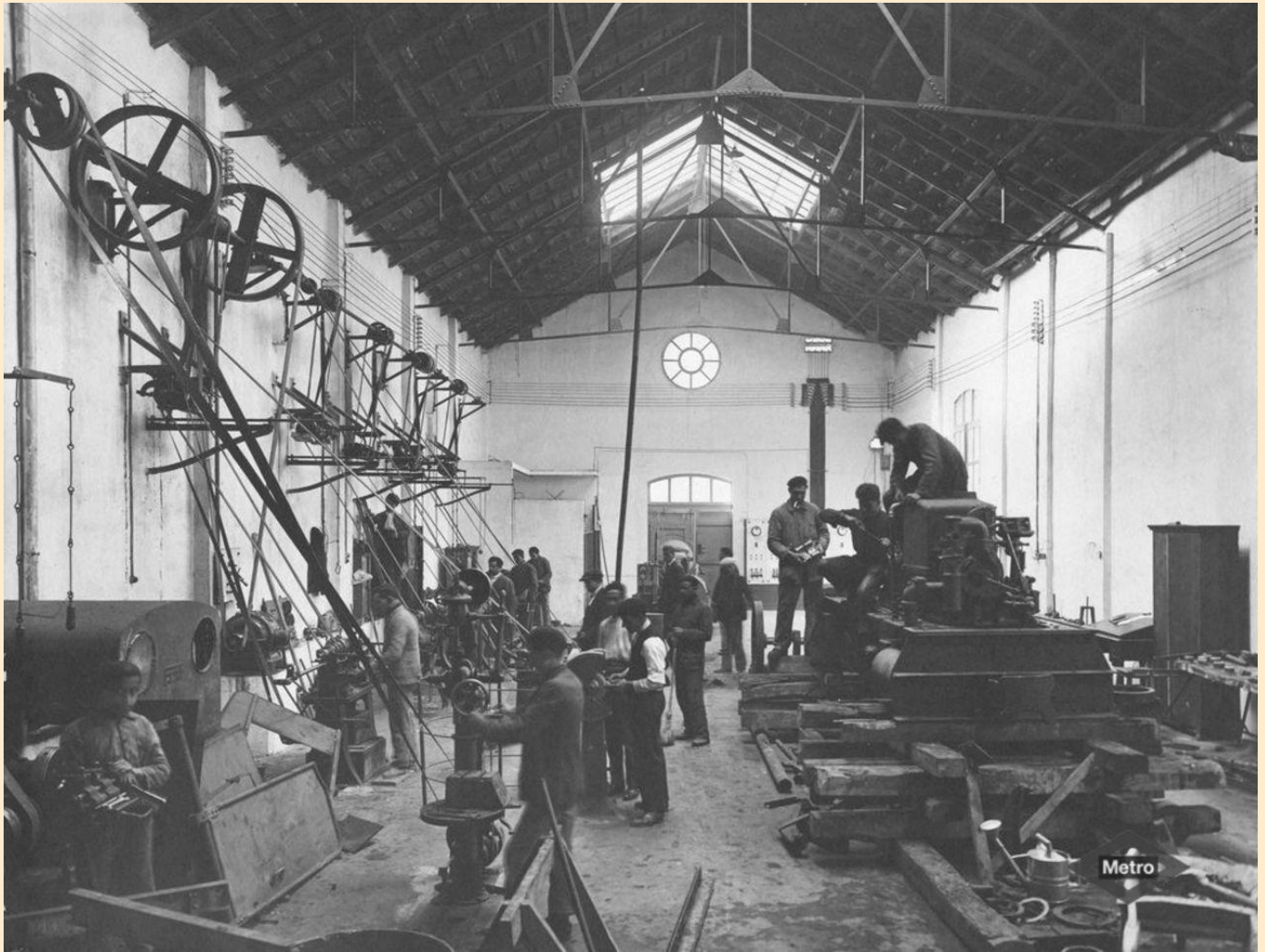
Interior de la nave C de las Cocheras de Cuatro Caminos. Fuente: Archivo Fotográfico de Metro de Madrid.
