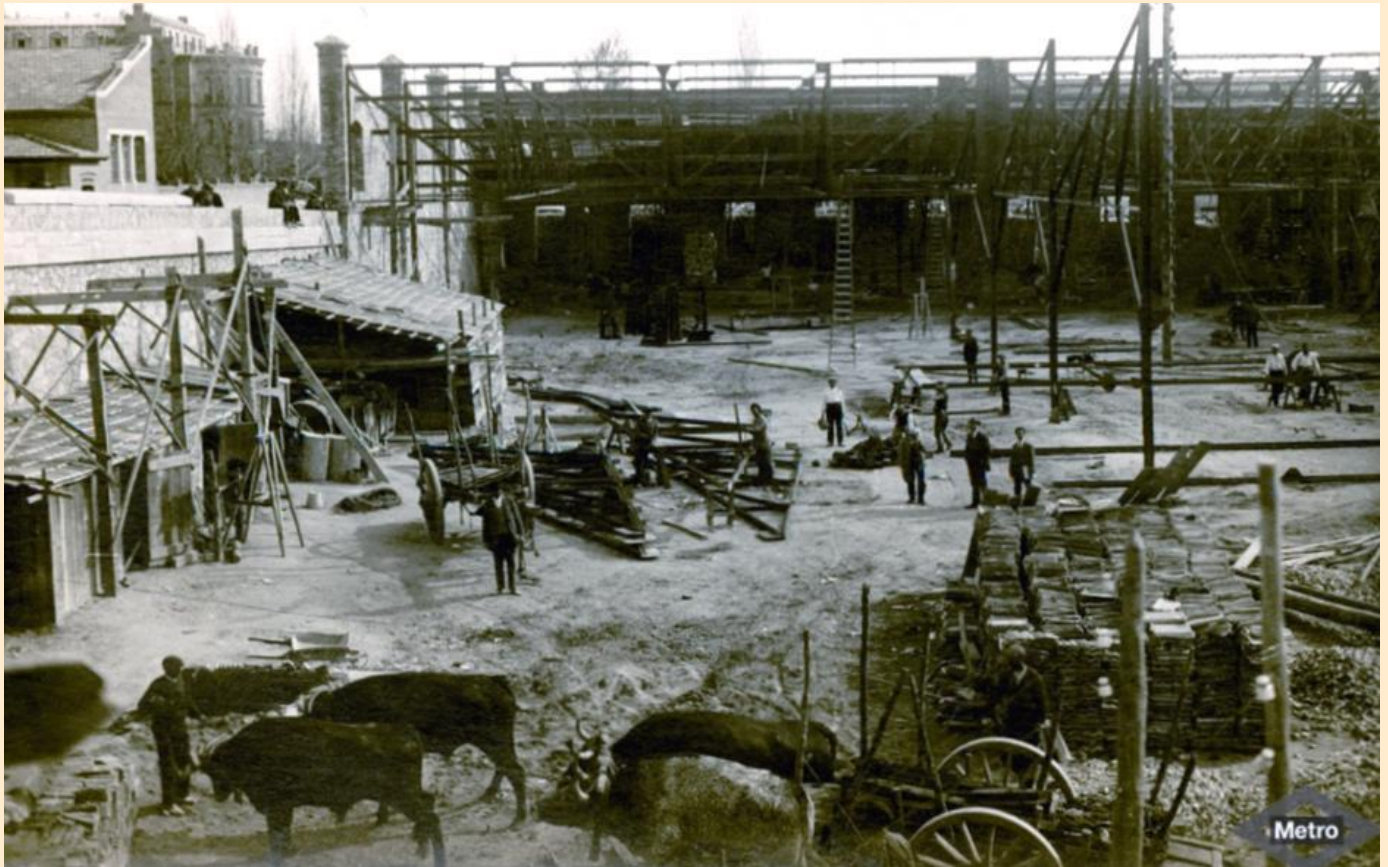
Construcción de las cocheras de Cuatro Caminos. Falta mucho para que en la calle de Esquilache surja la fachada oeste del Edificio Azafata, por lo que hay visión directa del Colegio El Porvenir (esquina superior izquierda). Fuente: Archivo Fotográfico de Metro de Madrid.
