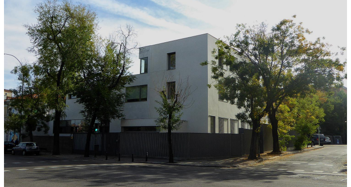
Arriba, la esquina de las calles de Mateo Inurria y de Daniel antes del derribo de los viejos edificios chamartineros. Debajo, el inmueble de viviendas que se alza actualmente en su solar.
