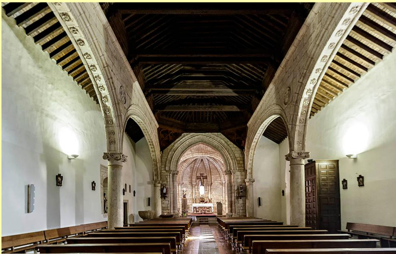
Foto 12. Perspectiva general hacia la cabecera del templo, evidenciándose la gran nave central, las cubiertas lignarias y la cabecera medieval.
