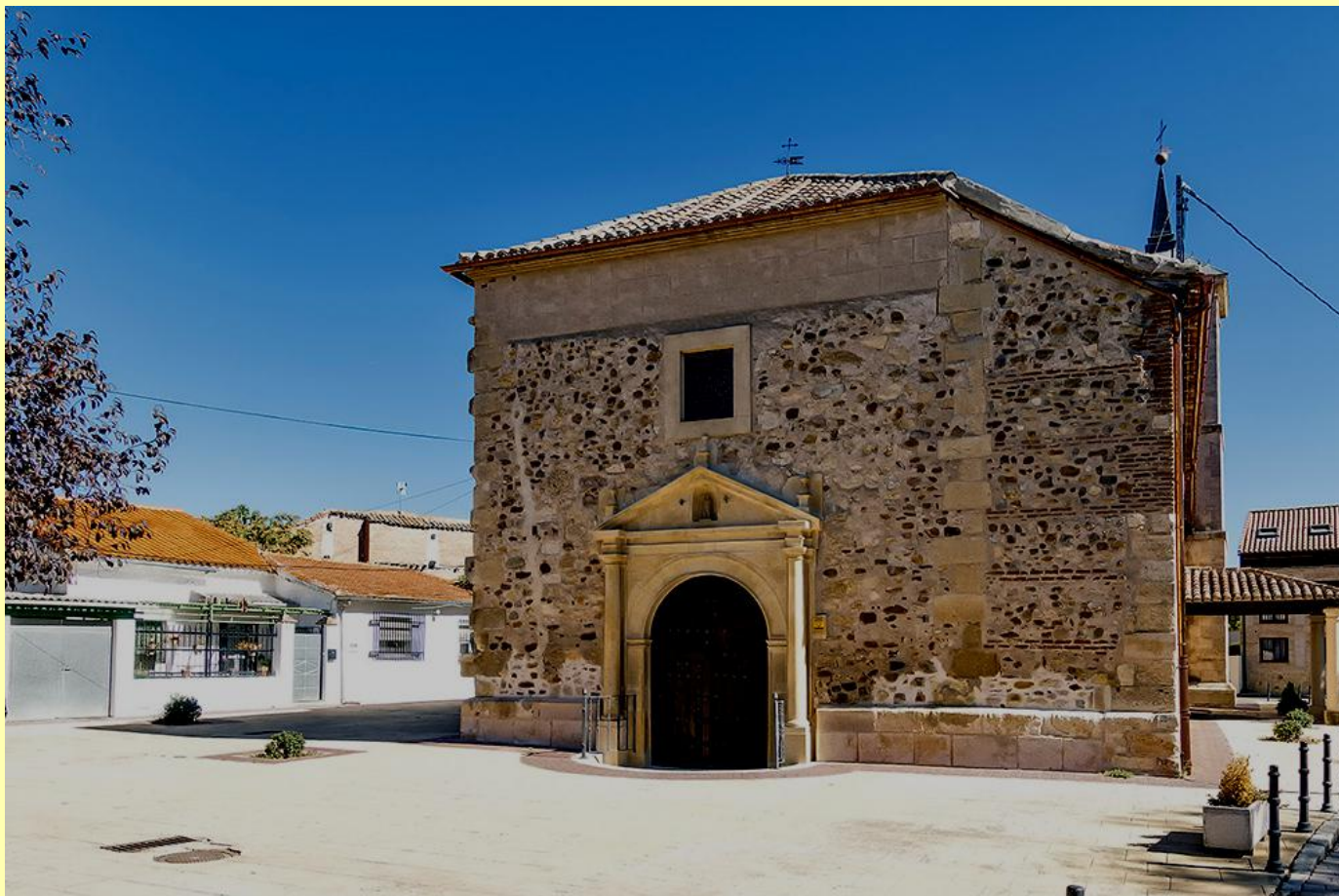
Foto 10. Fachada principal del templo, mostrando su configuración asimétrica, así como su portada de equilibrado clasicismo.
