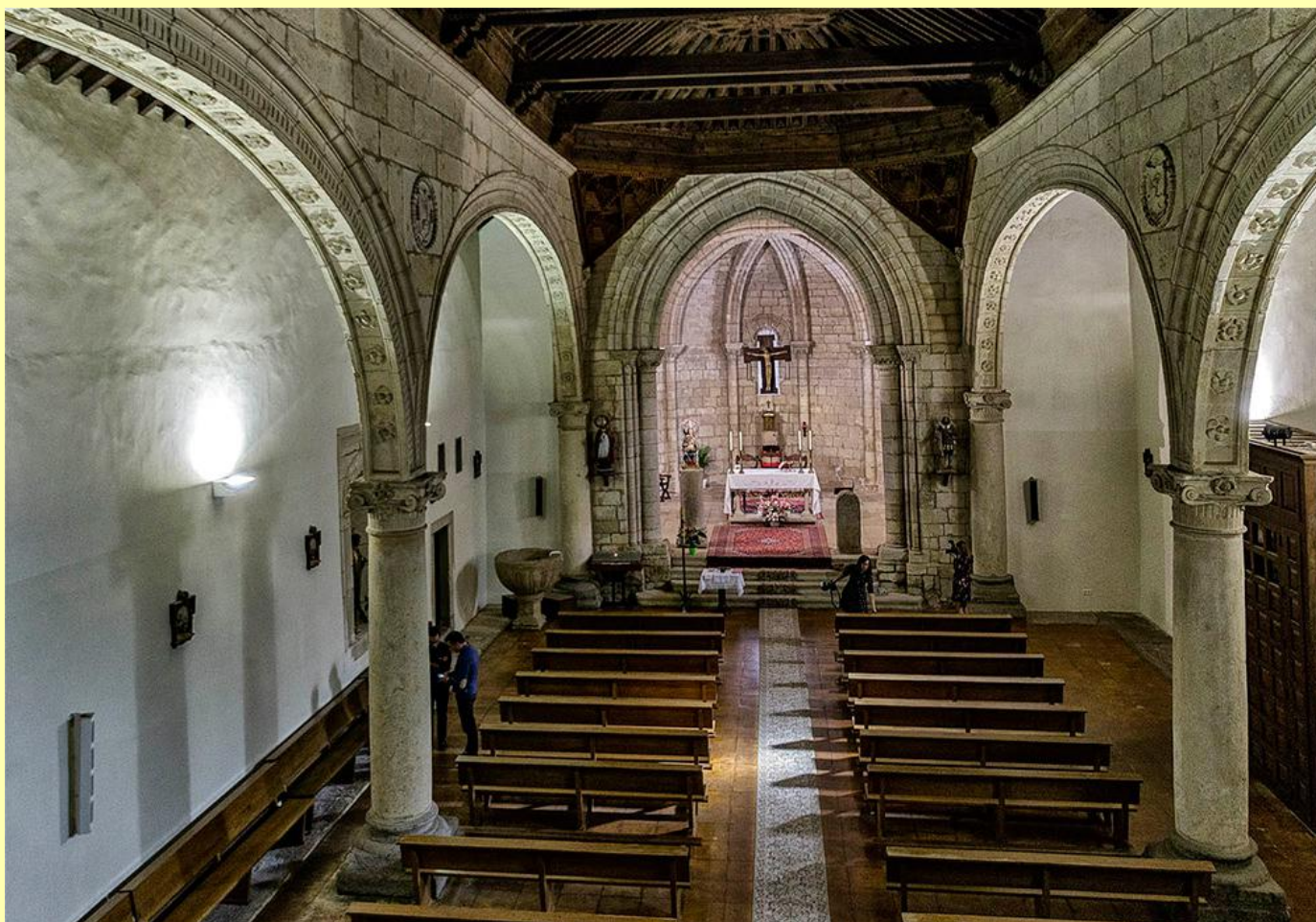
Foto 15. Perspectiva de las naves del templo, en la que se aprecian las arquerías renacentistas que lo estructuran en tres naves.
