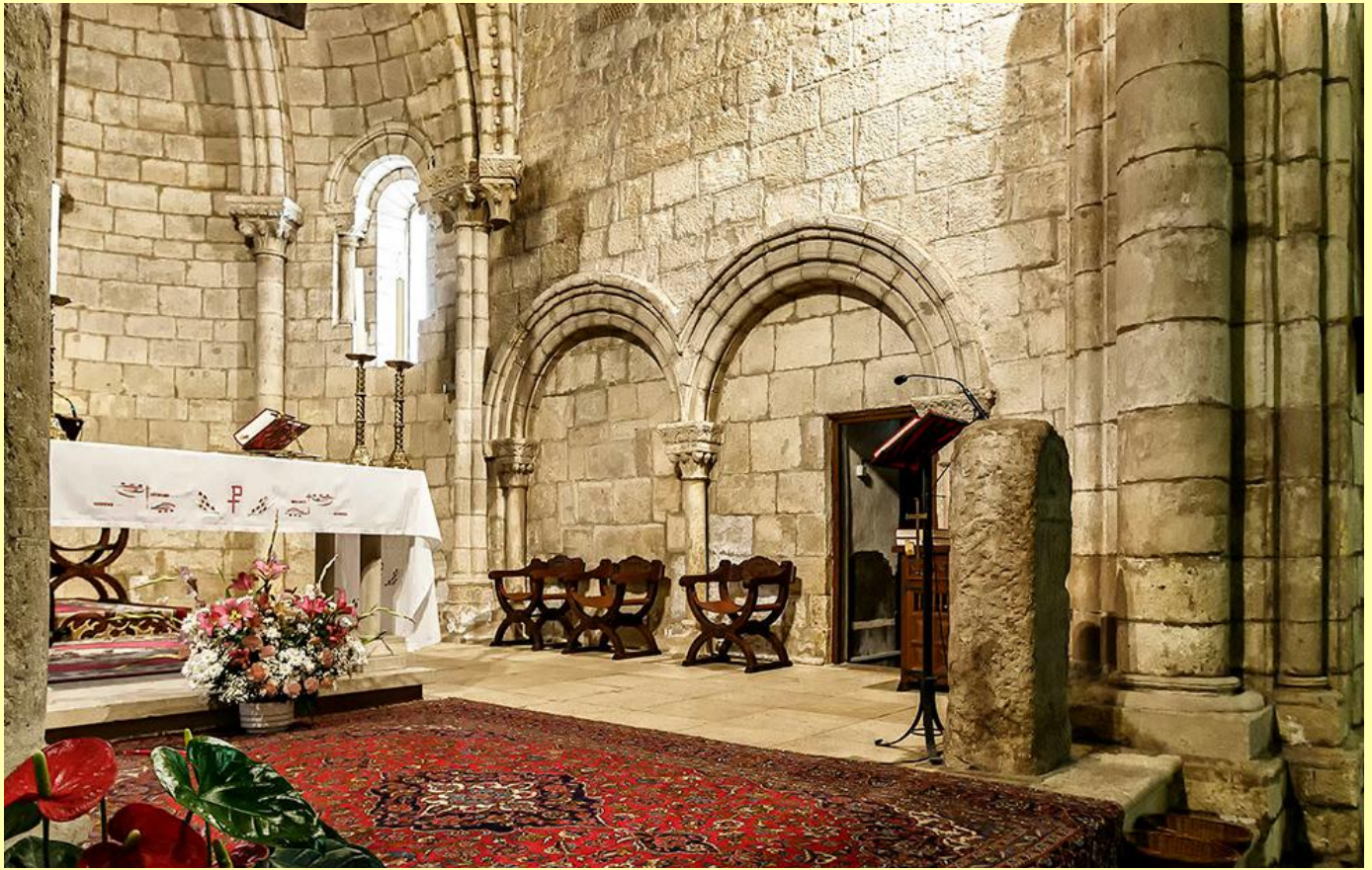
Foto 20. Doble arquería ciega de medio punto en el paramento meridional del presbiterio.
