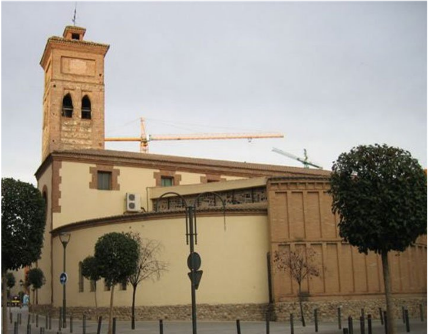
Gran ábside contemporáneo de la fachada sur de la iglesia.
