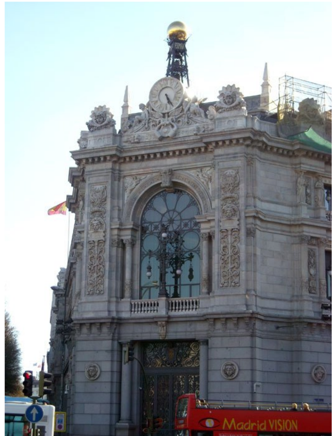
Fachada del Banco de España
