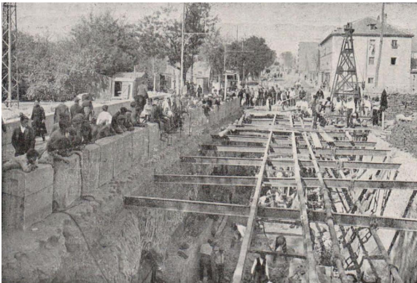
Fotografía de las obras de construcción en el Puente de Vallecas. Fuente: "El Metropolitano Alfonso XIII - Atocha-Puente de Vallecas", publicado en "La Ilustración Financiera", 1923.
