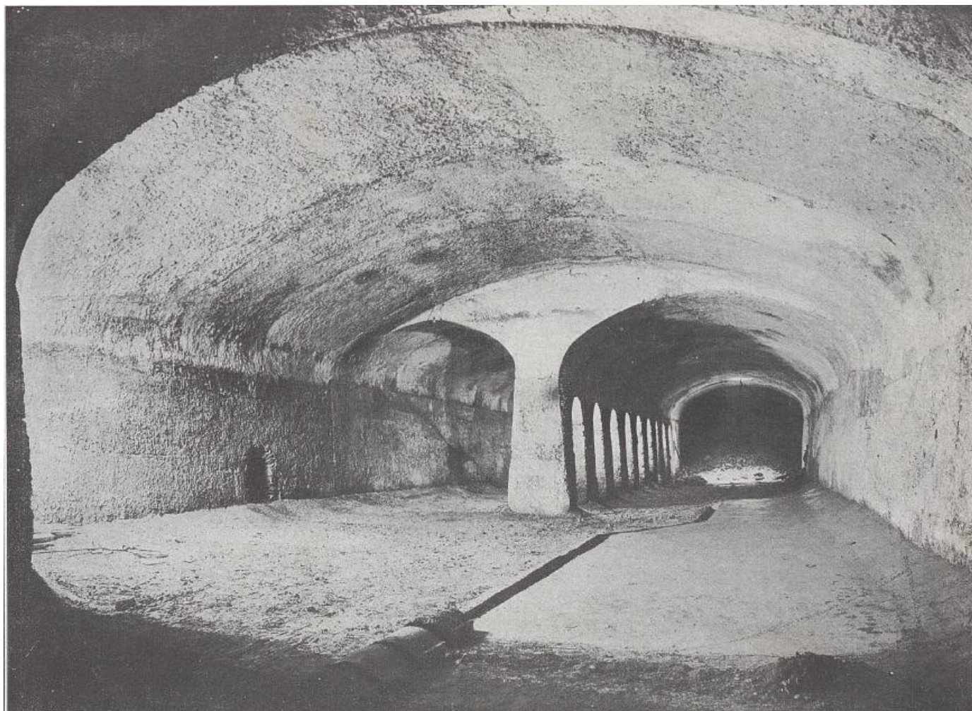
Fotografía de la bóveda auxiliar para la vía apartadero de Atocha, comprendida entre la estación original de Atocha y la posterior de Atocha-Renfe, construida ya en los años 80 del siglo XX. Fuente: OTAMENDI, Miguel: Compañía Metropolitano Alfonso XIII: Línea Norte-Sur – Trozo Sol-Atocha. Madrid, 1921.
