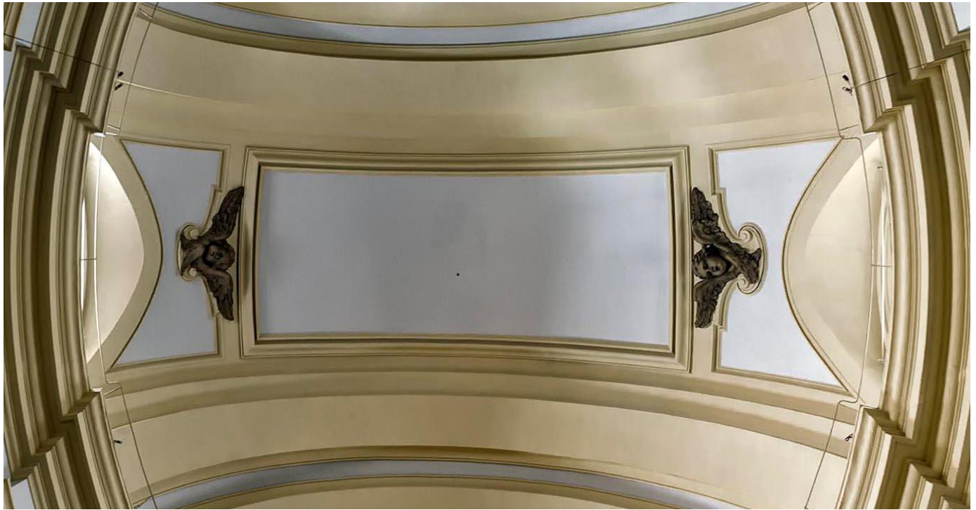
Foto 9. Bóveda de la nave, evidenciando su planta elíptica.
