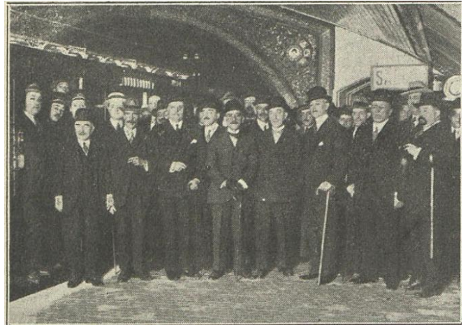
Fotografía de las autoridades en la Estación del Puente de Vallecas durante su inauguración. Fuente: "Metropolitano Alfonso XIII. Inauguración del trozo Atocha-Puente de Vallecas", publicada en "El Financiero", 11 de Mayo de 1923.
