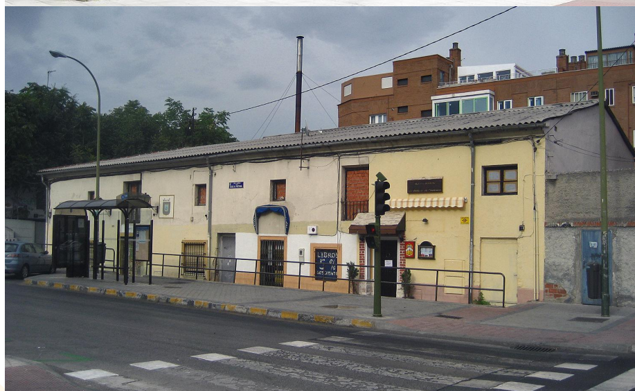
Estado actual del solar en el que se levantaba el primer ayuntamiento de Chamartín de la Rosa, resultado del derribado, en 2016, del edificio construido hacia el año 1930, que reproducimos en la imagen pequeña. (Fotografías: Mario Sánchez Cachero).
