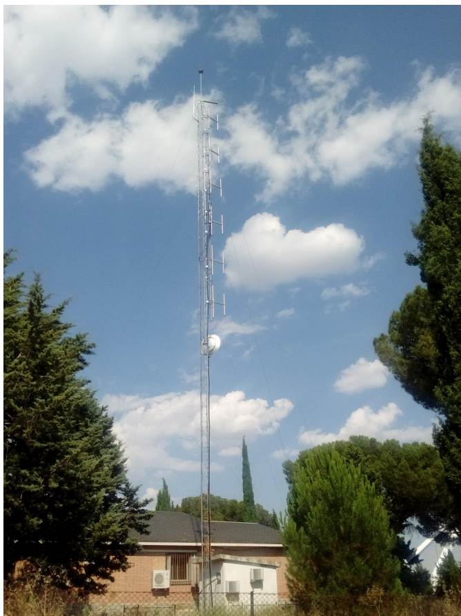
Mástil del centro emisor del Pinar de las Rozas, de la antigua emisora La Voz de Madrid. Hoy está desafectado de su función original de Onda Media y alberga varias antenas dipolo de Frecuencia Modulada.
