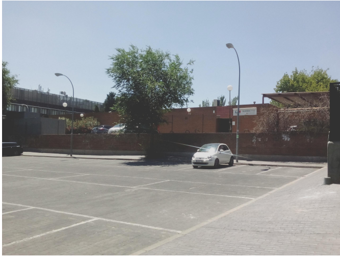
Centro de Salud ubicado sobre los terrenos de la antigua emisora de Radio España.
