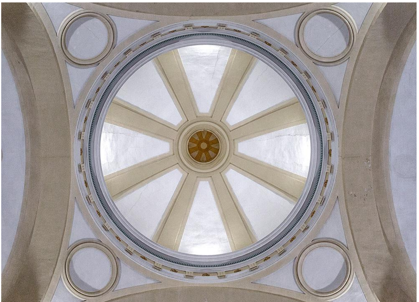
Foto 17. Vista de la espléndida cúpula encamonada del crucero. Siglo XVIII.
