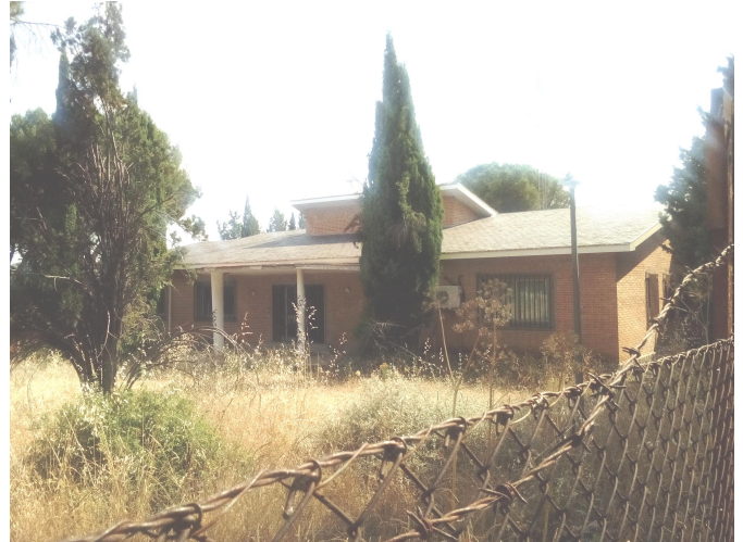
Detalle del edificio técnico del centro emisor del Pinar de las Rozas.
