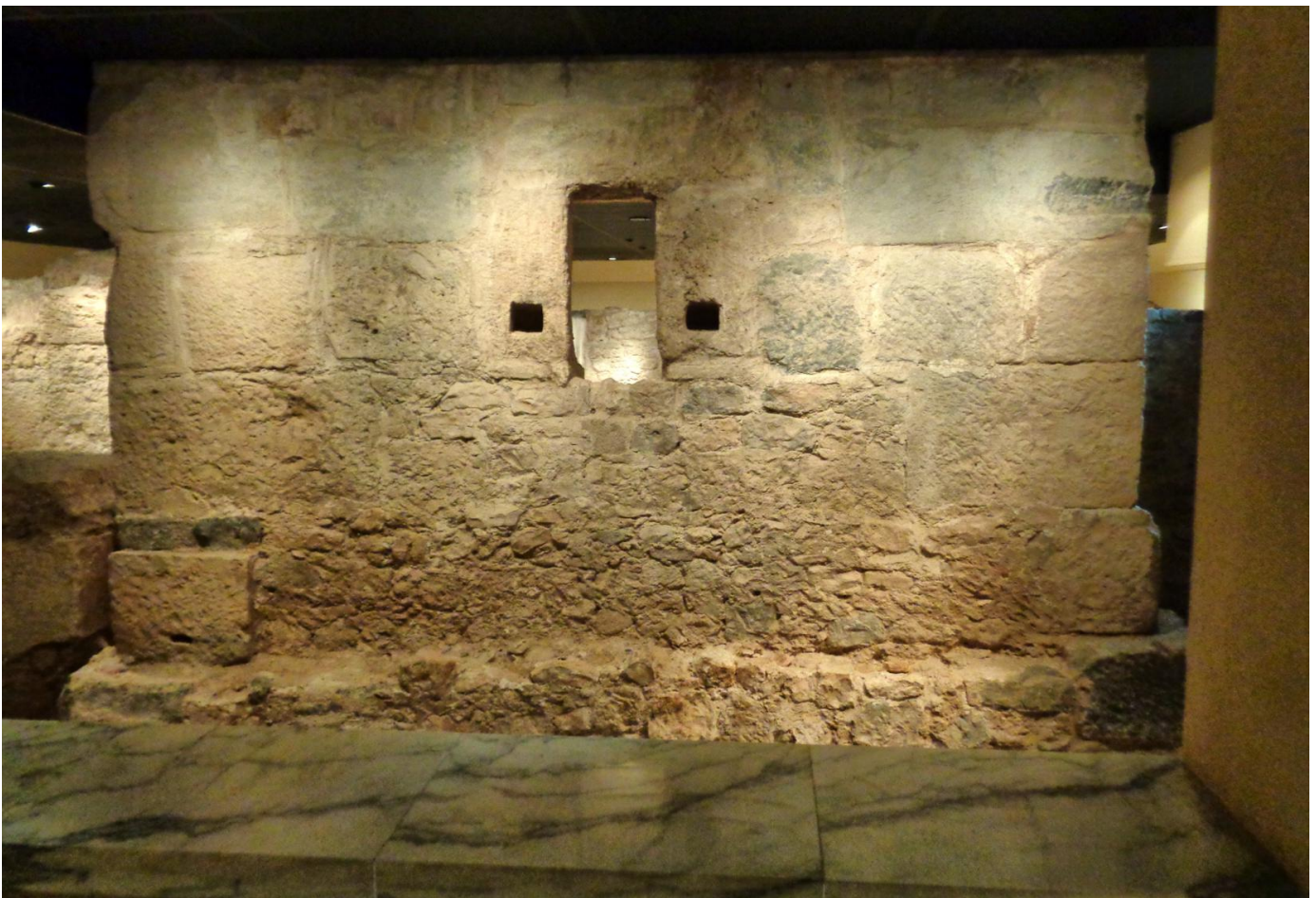
Foto 19: Fachada del brazo norte del crucero, en la que se abre un vano rectangular de disposición vertical.
