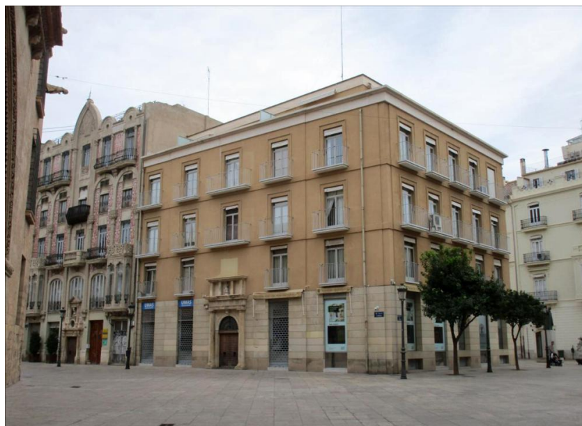
Foto 12: Fachada del moderno edificio a la plaza de Décimo Junio Bruto, que muestra la portada neoclásica de acceso a la capilla de la Cárcel de San Vicente. En su sótano se encuentra la Cripta Arqueológica (Fuente: http://www.jdiezarnal.com/valenciacriptadesanvicente.html ).
