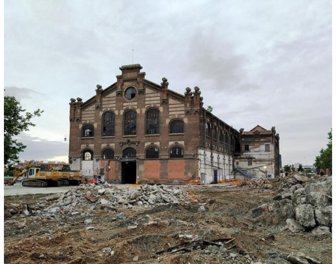
Nave de motores de la antigua fábrica eléctrica de la Sociedad Gasificadora Industrial, en obras en la actualidad para acoger oficinas del grupo Acciona.
