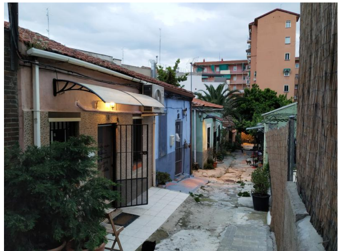
Viviendas del Callejón de Cavanilles, infravivienda del siglo XIX que ha perdurado hasta nuestros días, en pleno centro de la ciudad. Sin duda, una de las estampas más curiosas del barrio del Pacífico.
