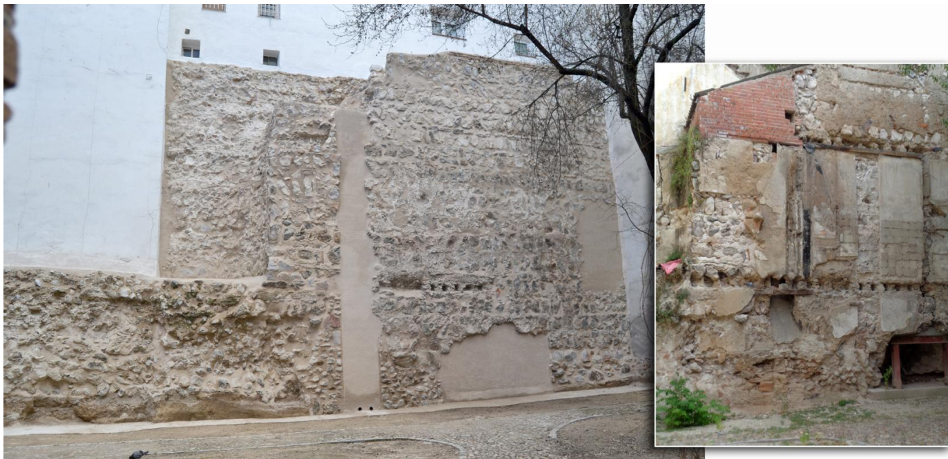
Foto 7: A la izquierda, tramo de muralla castellana (S. XII-XIII) existente en la calle del Almendro, antiguos números 15 y 17. A la derecha, aspecto de ese mismo tramo de muralla con carácter previo a su restauración.
