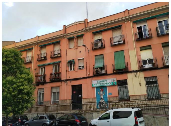
Fachada principal de una corrala en la calle de La Regalada. Obsérvese que el edificio está a mayor altura que la calle, probablemente porque cuando se construyó la corrala, ubicándose allí el Camino Viejo a Vicálvaro, éste tenía mayor cota que la calle actual.
