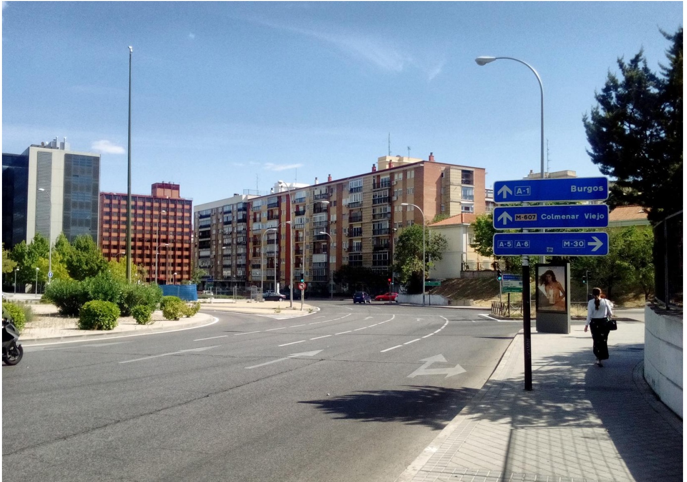
Vista más alejada de los edificios del tramo inicial.
