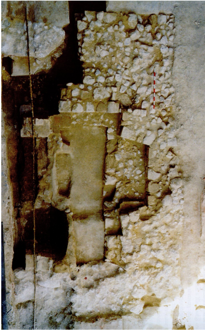
Restos de los distintos ábsides, visibles bajo una ventana arqueológica en la calle de la Almudena: en la esquina superior izquierda, arranque curvo del ábside románico; en el centro, contorno poligonal del ábside y camarín de 1638 (Fuente: Ilustración de Madrid , nº 19, 2011, p. 49).
