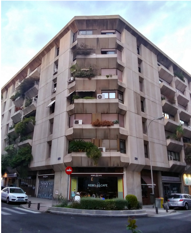
Detalle del edificio Géminis-1, con su característico color grisáceo de módulos de hormigón al descubierto.
