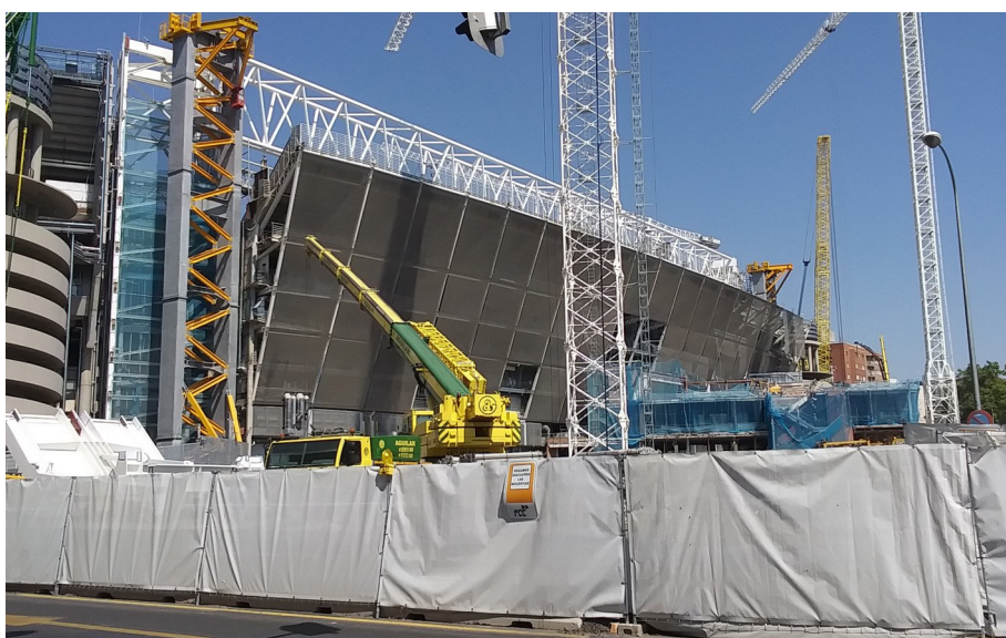
Estado de la actual reforma a mediados de julio de 2020. Arriba: Fachada lado Paseo de la Castellana. Abajo: Lado Padre Damián (Fotos: Juan Pedro Esteve García).
