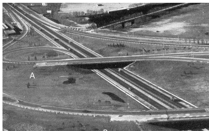
Nudo Eisenhower de Madrid en su estado posterior a 1967. Con las letras A y B se señalan los espacios previstos para la llegada de dos calzadas procedentes del sur como -entonces- futura conexión con el eje de O'Donnell (Foto: autor desconocido).
