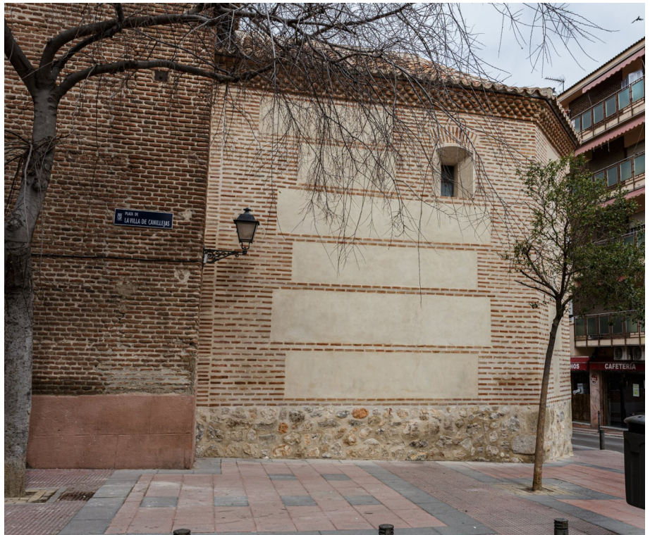
Foto 9: Vista de la fachada meridional del remozado ábside medieval.
