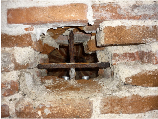
Hueco respiradero entre los compartimentos del sótano (Foto: Rafael Martín Moyano).
