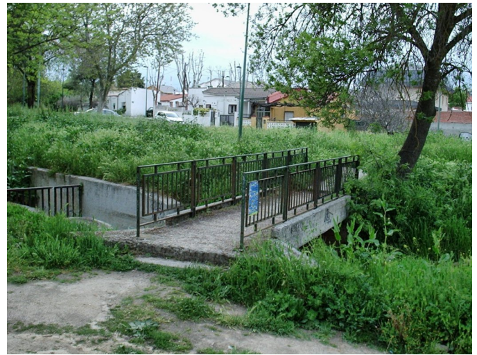
Puente sobre el Arroyo Meaques. A menudo va seco en esa parte del recorrido, pero dispone de esta pequeña construcción para avenidas de agua excepcionales.
