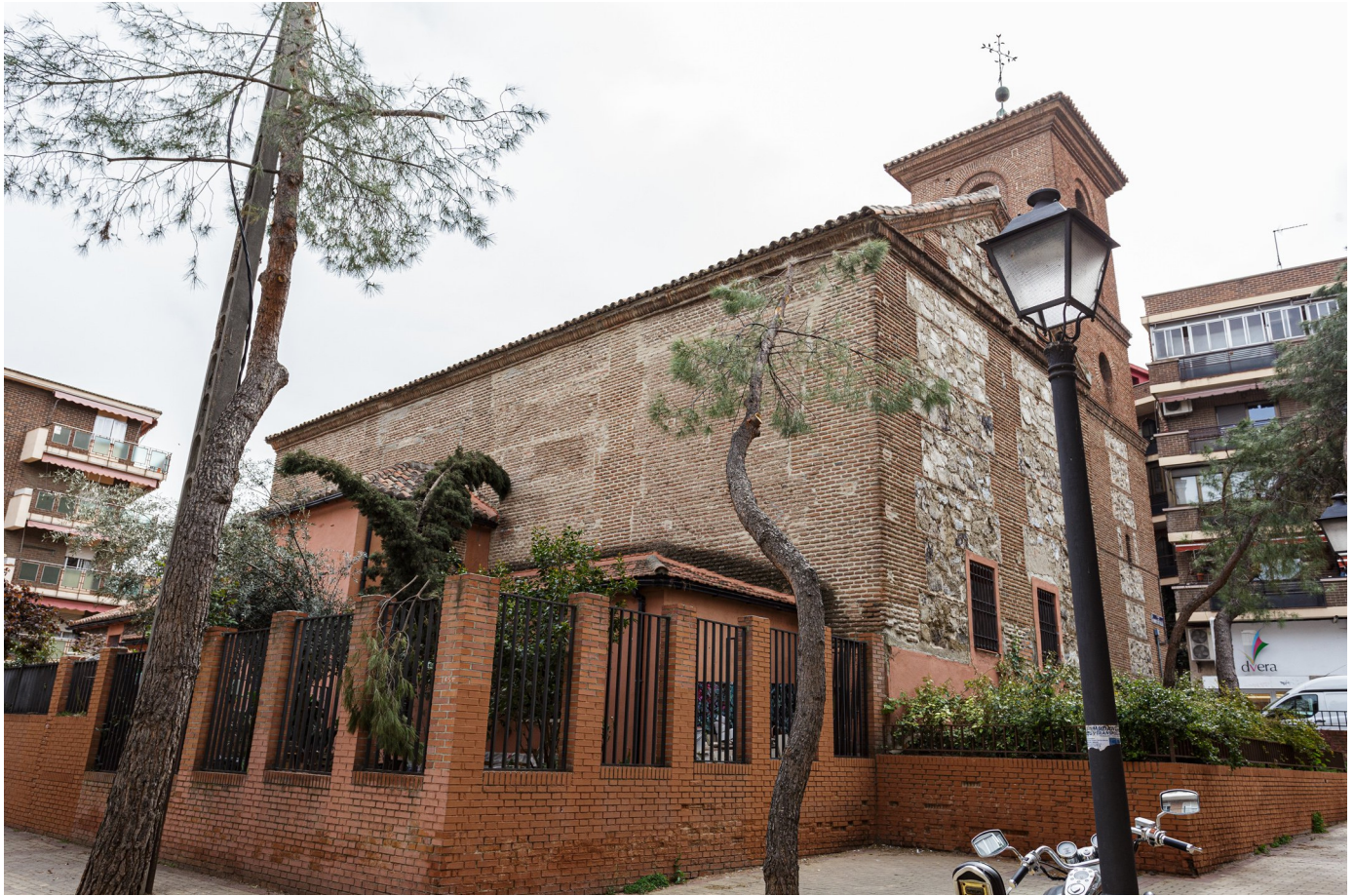
Foto 11: Fachada septentrional del templo con el atrio o compás delimitado mediante tapia enverjada.
