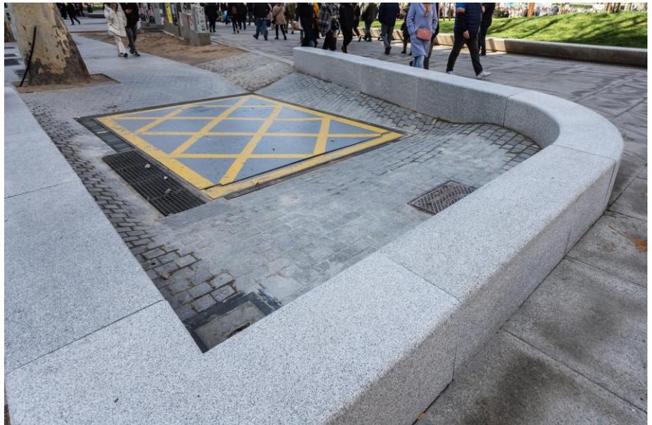
Foto 16: Salida de emergencia de Metro deprimida en relación a la rasante del terreno en que se abre y cercada de granito.
