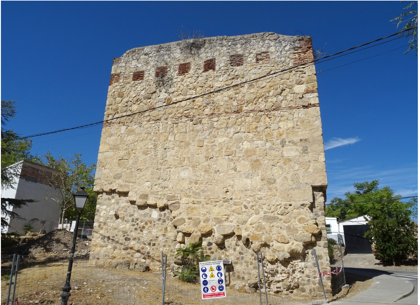
Foto 7: Puerta-torreón de Uceda, vista desde su fachada suroriental.
