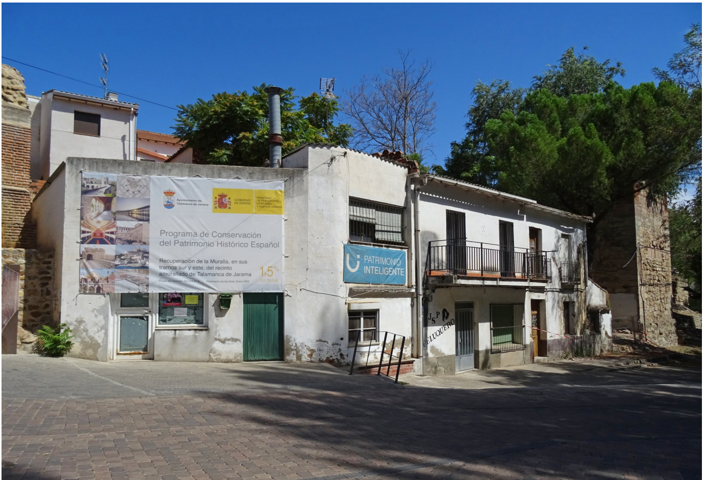
Foto 19: Casas adosadas a la fachada exterior de la muralla que serán inminentemente demolidas.
