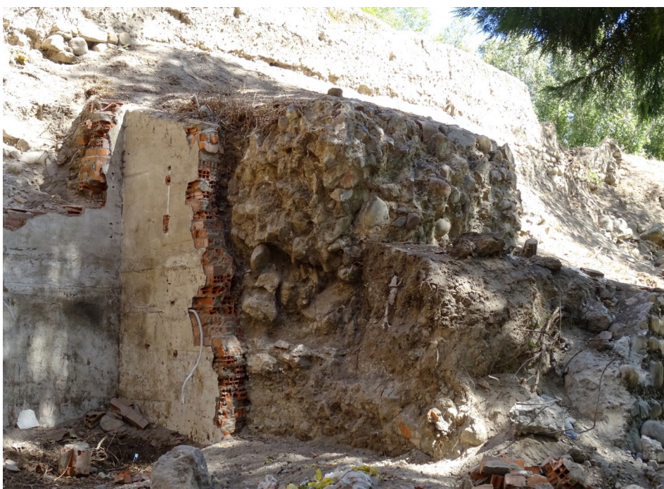
Foto 17: Nuevo torreón recuperado tras la demolición del taller de metalistería.
