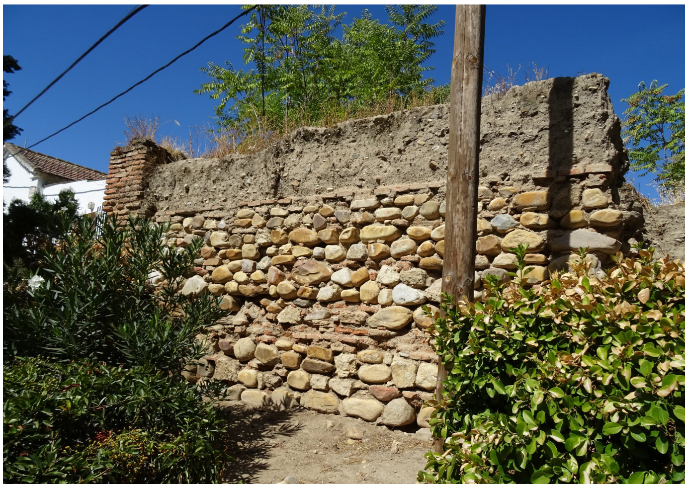
Foto 6: Posible torreón de flanqueo de la puerta de Uceda, modificado tras su integración en la Cartuja de Talamanca.
