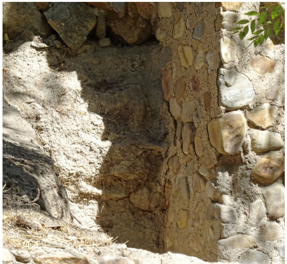
Foto 15: Cata abierta en el lateral meridional del torreón, que permite apreciar su buena conservación.
