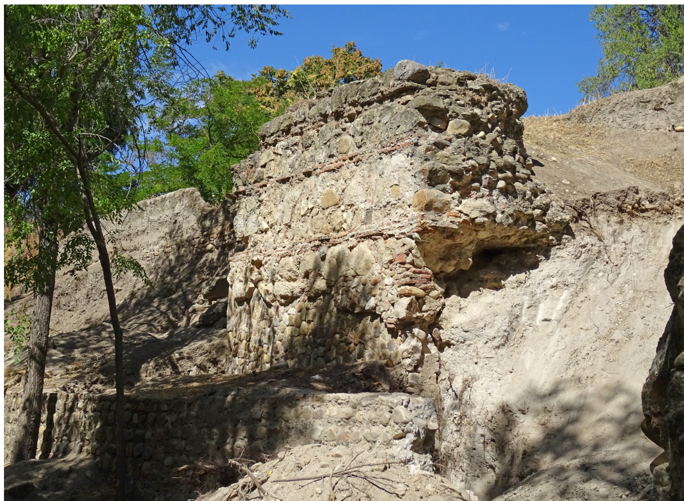
Foto 13: Vista de la fachada principal, y de la septentrional del primer torreón del sector meridional.
