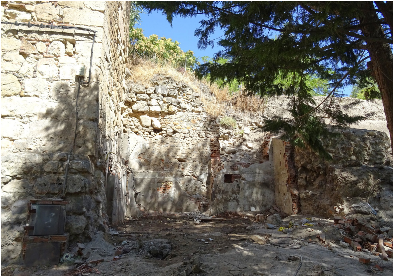
Foto 16: Nuevo tramo de muralla a la vista tras el derribo del pequeño taller de metales que lo ocultaba.
