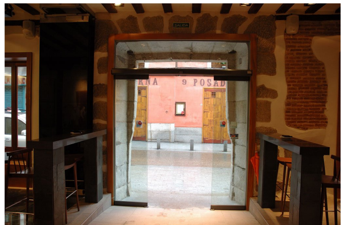
Pequeña rampa de acceso en el umbral para salvar el desnivel
