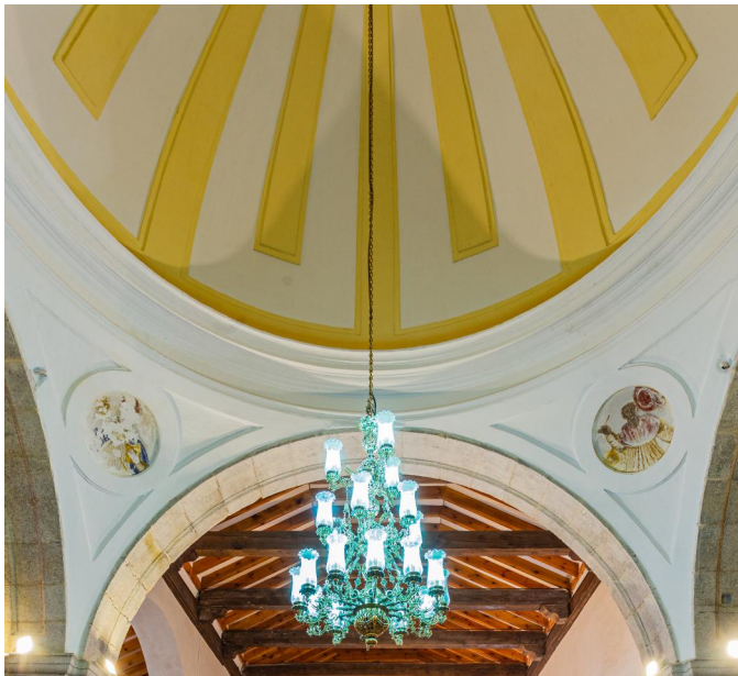
Foto 17: Vista parcial de la cúpula que cubre el crucero.
