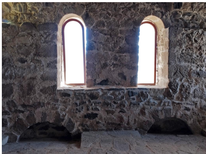
Foto 28: Muro oriental de la primera planta de la torre. En la parte inferior, parte de los huecos de campana de la antigua espadaña románica de comienzos del siglo XIII (Foto: José Manuel Castellanos Oñate).
