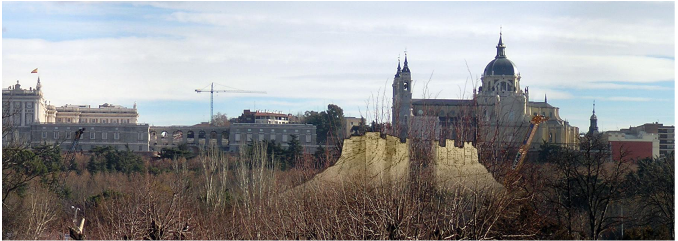
Sector de la panorámica de Wyngaerde correspondiente al tramo de muralla encontrado, y encaje aproximado en la cornisa de la Almudena. Se ha suprimido en el dibujo de Wyngaerde la parte inaccesible bajo el brazo occidental de la Catedral.
