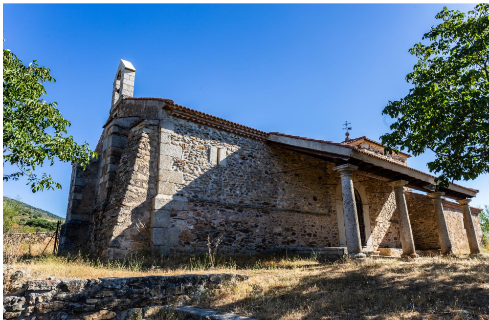
Foto 2: Vista de la fachada suroccidental de la ermita del Buen Suceso, con su pórtico columnado. Siglo XVII.
