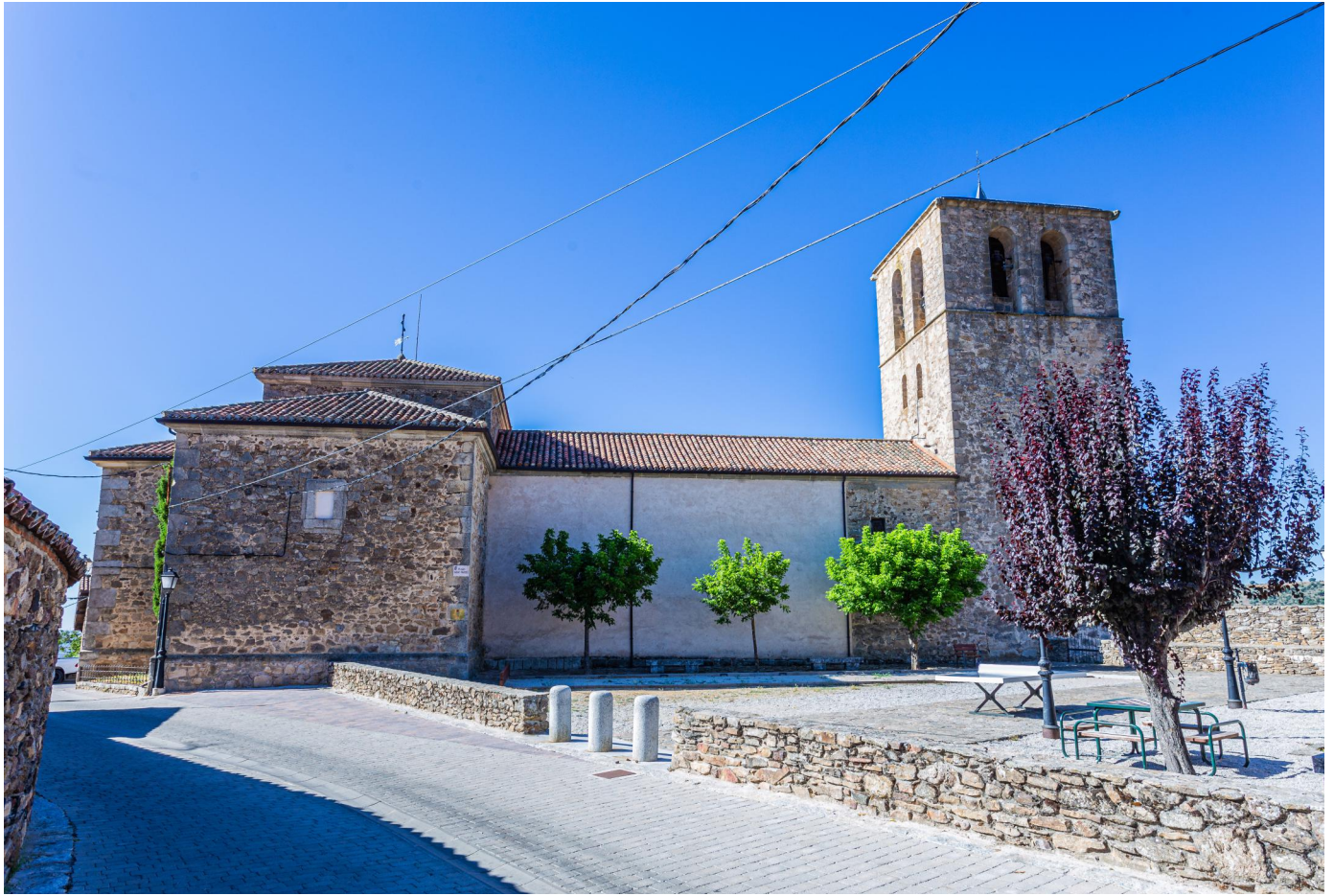
Foto 5: Fachada norte del templo de San Vicente Mártir, mostrando parte de su paramento enlucido de blanco, correspondiente a la edificación original de los siglos XI-XII.
