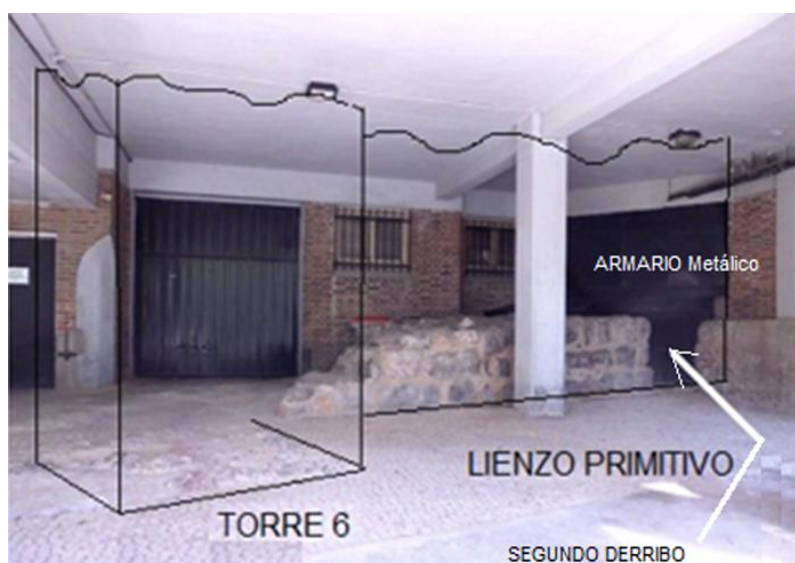
Fig. 6. Parte baja del edificio Bailén 12. La torre 6 derribada se representa por sus bordes.
