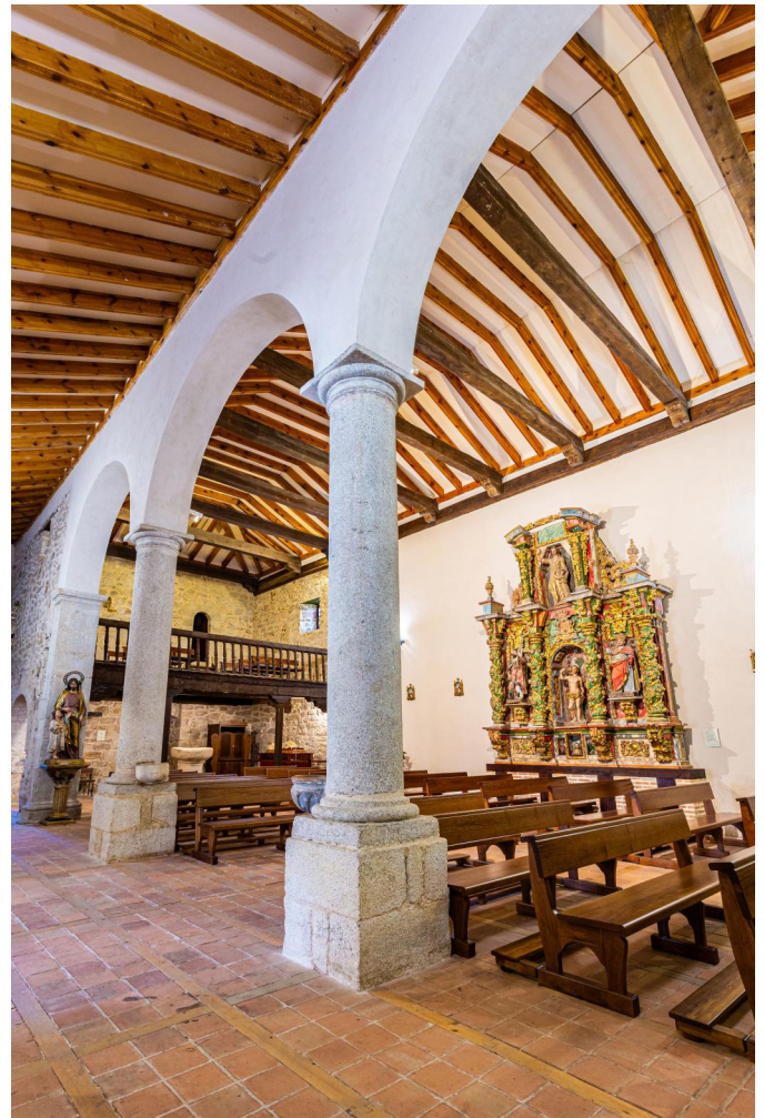
Foto 25: Perspectiva desde la cabecera de la nave meridional, en la que se aprecia el coro y el estrecho arco de medio punto que permite el acceso a la primera planta de la torre.
