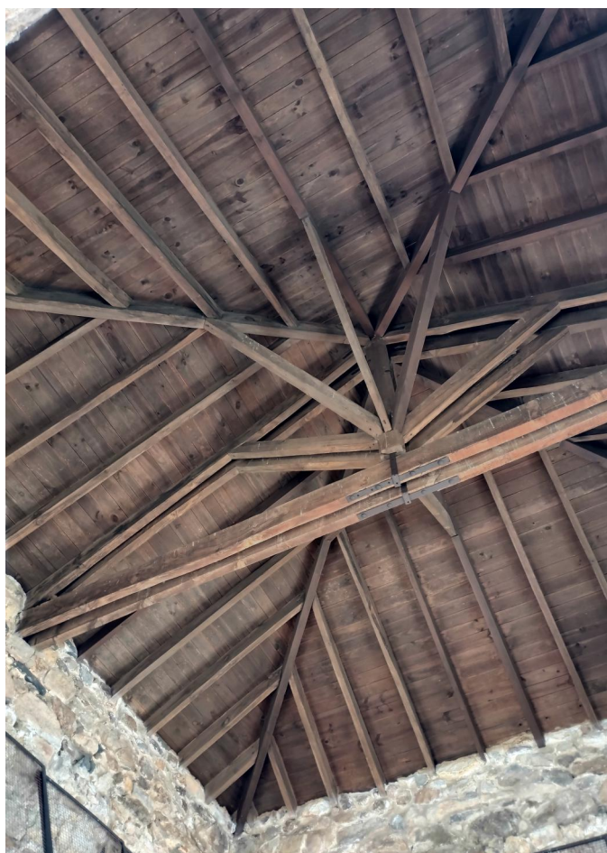
Foto 30: Armadura de madera a cuatro aguas que remata la torre-campanario del templo. Primer tercio del siglo XVII (Fotos de esta página: José Manuel Castellanos Oñate).
