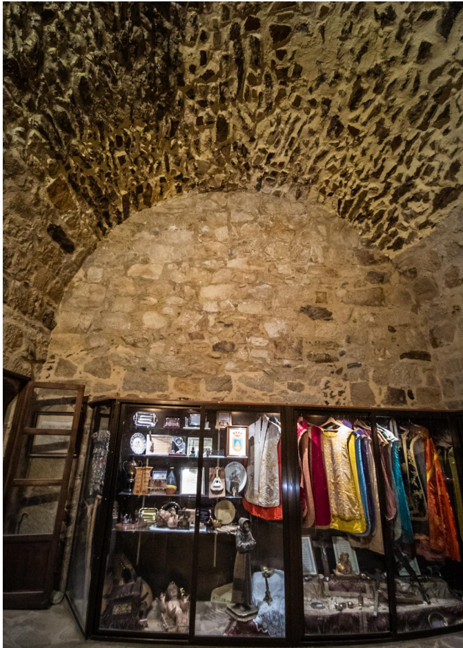
Foto 26: Sala en la primera planta de la torre, cubierta por bóveda de cañón de lajas y sillarejos.
