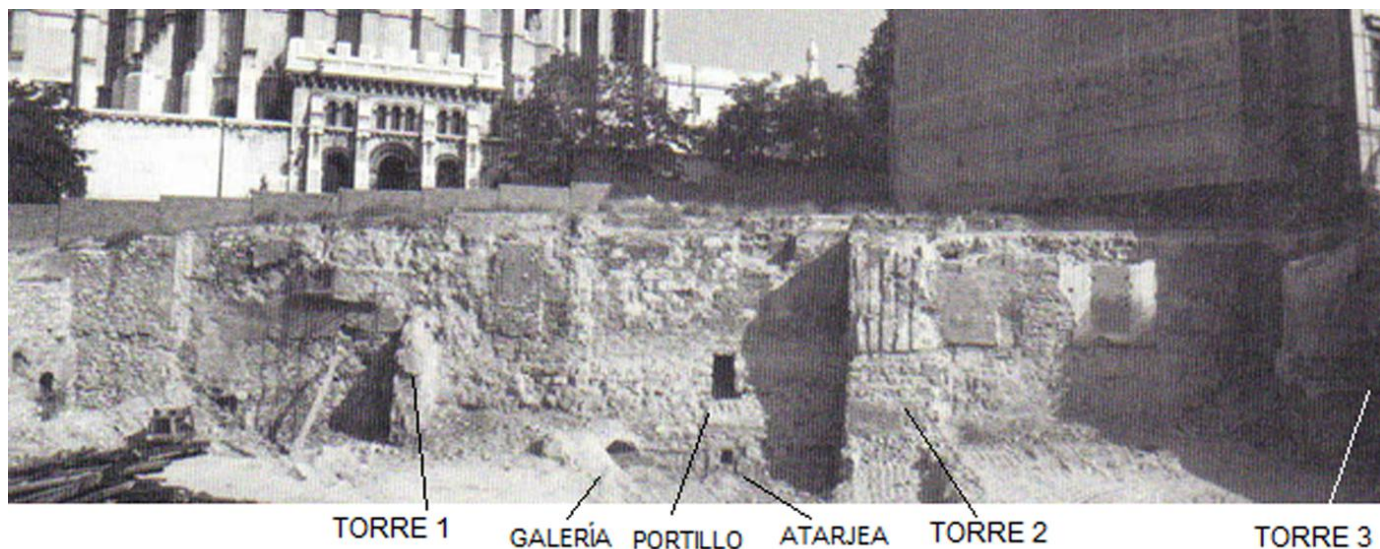
Fig. 10: La muralla del Parque del Emir recién descubierta. Se aprecia la atarjea debajo del portillo. La torre 1 se encuentra derribada en gran parte.
