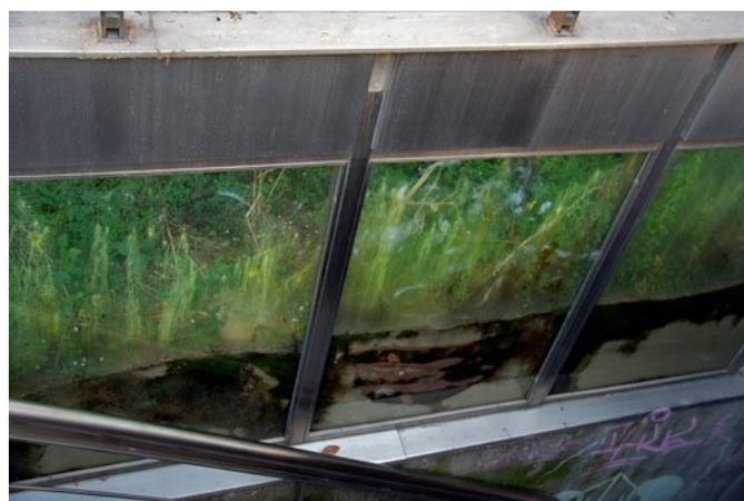
Acceso peatonal al aparcamiento subterráneo, con la recreación de la estratigrafía arqueológica deteriorada por la vegetación y las raíces
