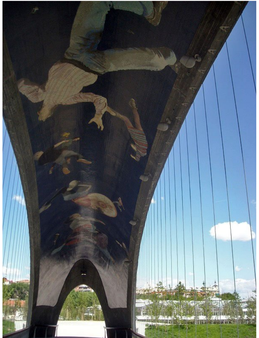
Puente del Matadero
