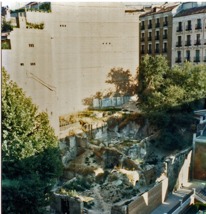
Aquí se aprecian los distintos niveles que tenía el solar de la Casa del Pastor. Foto Isabel Gea. Agosto 1987.
