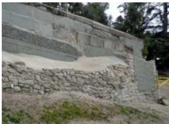
Fotos 6 y 7: Vista de las "ventanas" y demás remates hechos en los muros de contención después de pintarse de color gris todas las zonas reparadas.
