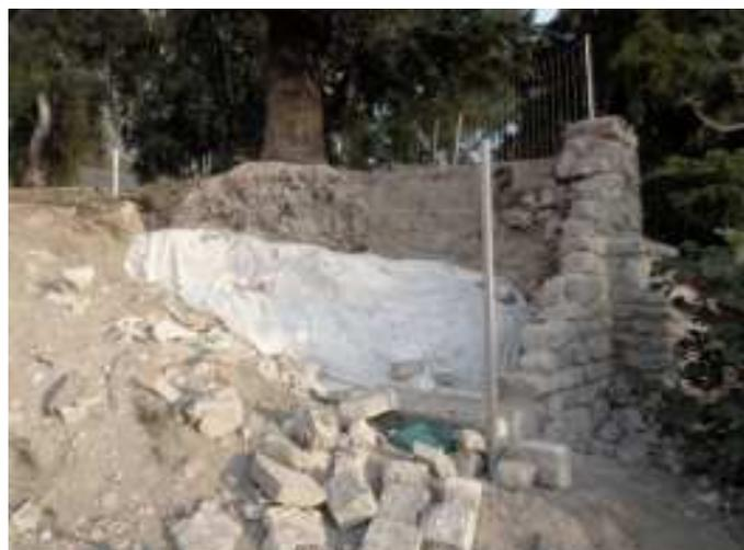
Al poco, la muralla se cubrió con manta geotextil y alrededor de su extremo oeste se rehizo el mirador con una pared escalonada de mampostería muy bien trabajada, quedando de nuevo oculto el muro (fotos 20 y 21).
