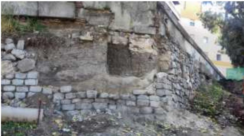
Fotos 2 y 3: “Ventanas” abiertas en el recubrimiento de rocalla de los muros de contención.
