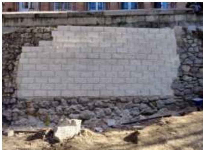
Foto 5: Aspecto final de una de las "ventanas", una vez tapiadas con muro de bloques de cemento blanco.
