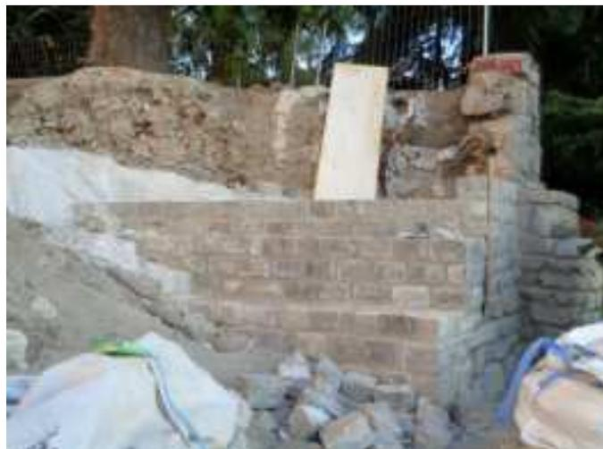
Fotos 20 y 21: Cubrición con manta geotextil del muro de la zanja 1 y reconstrucción del mirador, en dos momentos sucesivos de la obra. Tras su remate final, el muro vuelve a estar oculto bajo el suelo de los jardines.
