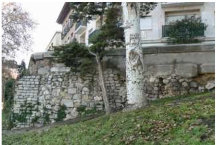
Foto 1: Estado del muro de rocalla (lado sur) antes de la intervención.
