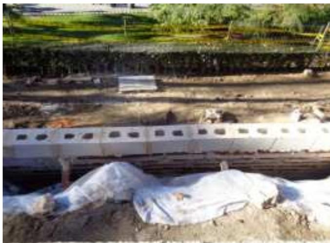
Foto 4: Vista cenital del cerramiento de las "ventanas", con manta de protección, cámara de separación y muro exterior de bloques de cemento.
