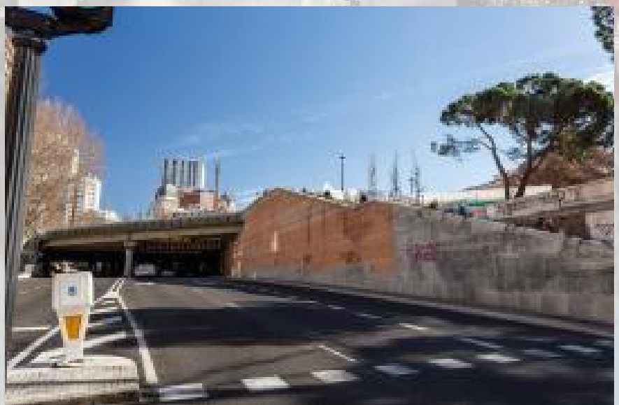
Foto 1: Vista general del paso elevado peatonalizado, y lateral de la escalinata de acceso.
