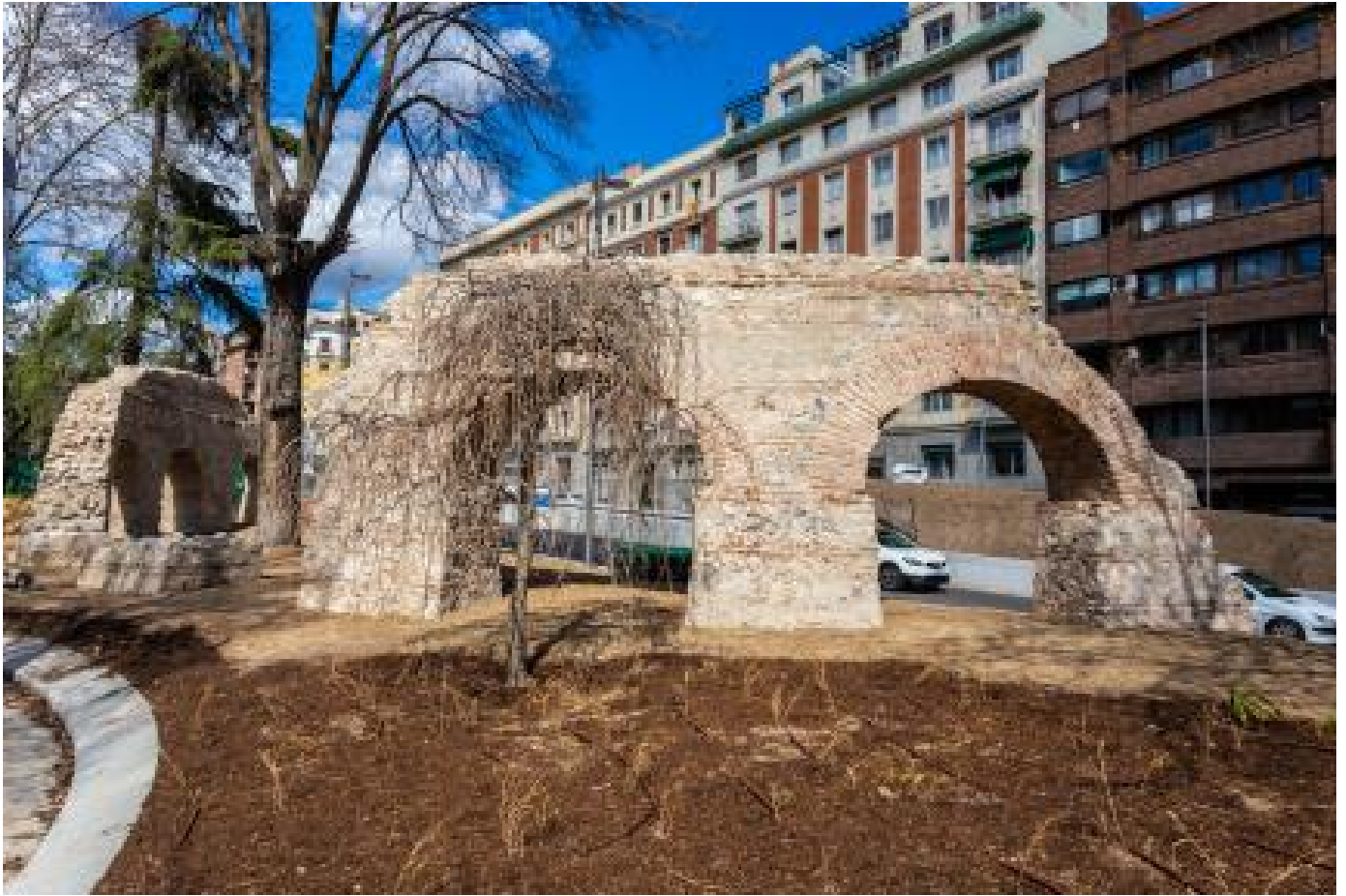
Foto 26: Vista de conjunto del bastión del cuartel de San Gil, tras su extracción del subsuelo y posterior montaje.
