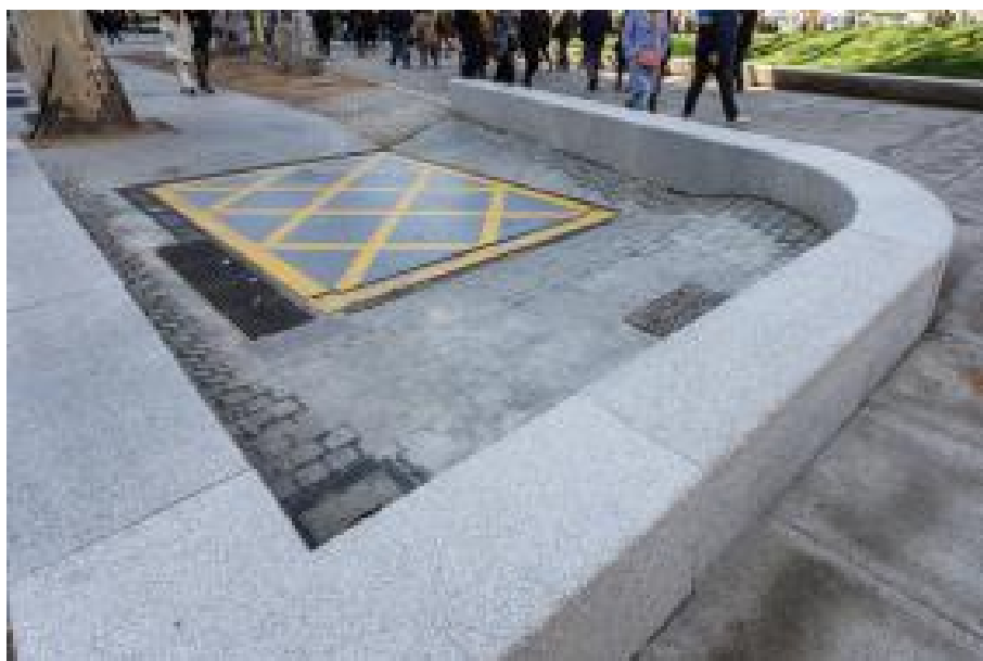
Foto 16: Salida de emergencia de Metro deprimida en relación a la rasante del terreno en que se abre y cercada de granito.
