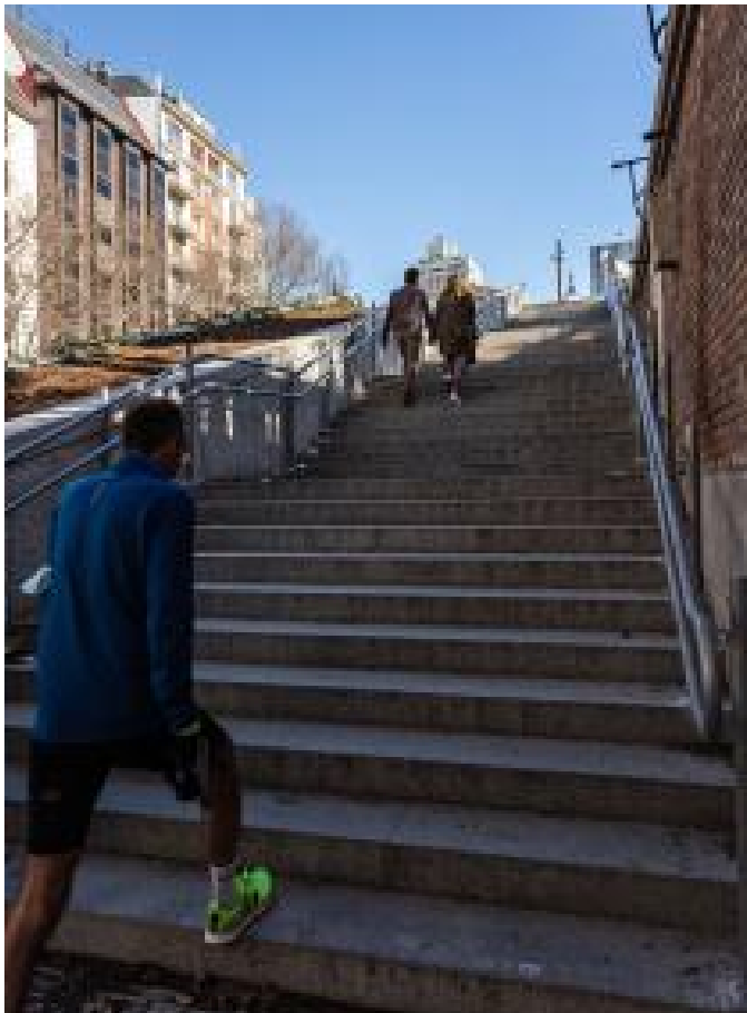
Foto 2: Escalinata meridional de acceso a la plaza de España y calle de Bailén desde la cuesta de San Vicente.
