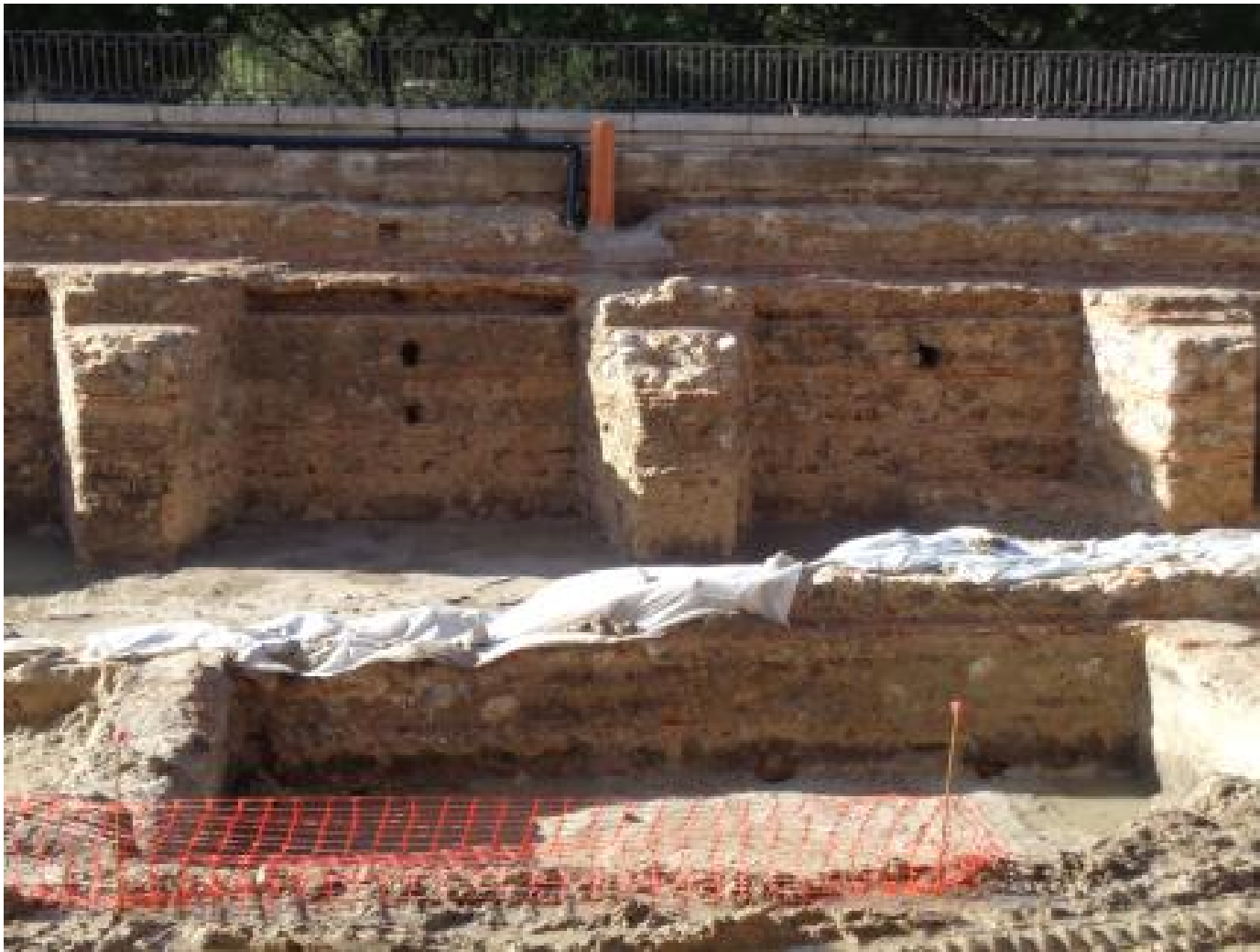
Foto 22: Vista del gran muro y contrafuertes diseñados por Sabatini para sustentar las desaparecidas Reales Caballerizas (Foto: Julio Real).
