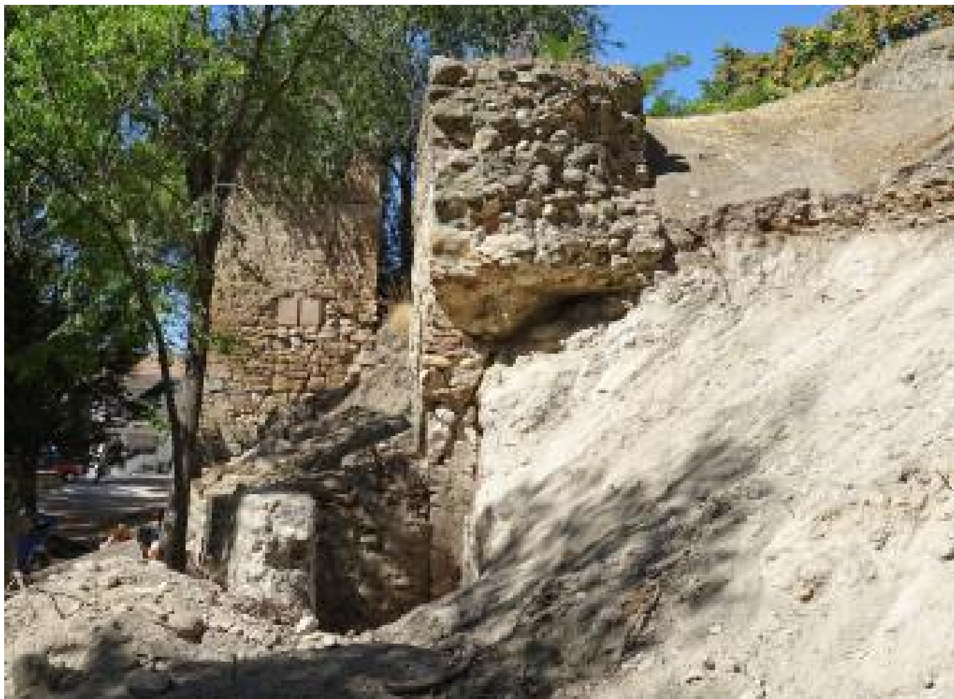
Foto 14: Cata abierta en la fachada principal de la torre, que permite constatar el nivel de su enterramiento por el talud.
