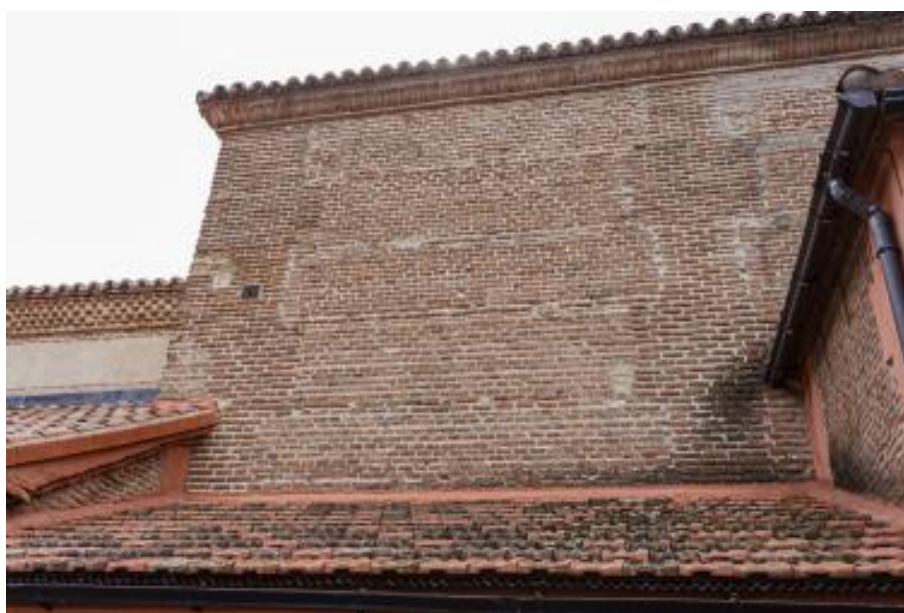
Foto 1: Muro correspondiente a la parte superior de la fachada septentrional del templo.
