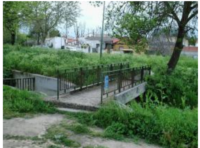
Puente sobre el Arroyo Meaques. A menudo va seco en esa parte del recorrido, pero dispone de esta pequeña construcción para avenidas de agua excepcionales.
