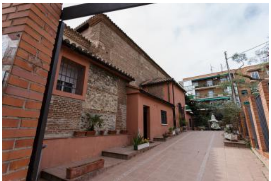
Foto 12: Vista general del compás o atrio de acceso al templo por su fachada septentrional.
