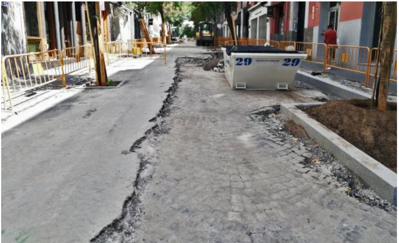
La calle del Almirante, con los adoquines a la vista.
