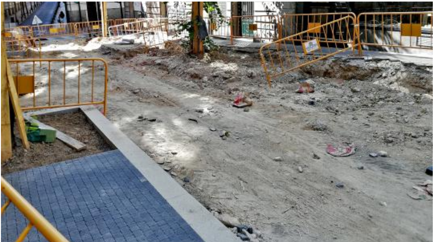
La misma zona de la calle del Almirante, fotografiada apenas una semana después. Los adoquines ya no se encuentran a la vista, posiblemente extraídos por las excavadoras.
