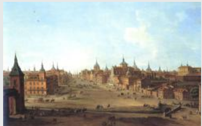
Remodelación Paseo del Prado y Castellana. A la izquierda del cuadro, el Palacio de Alcañices, donde hoy está el Banco de España.
