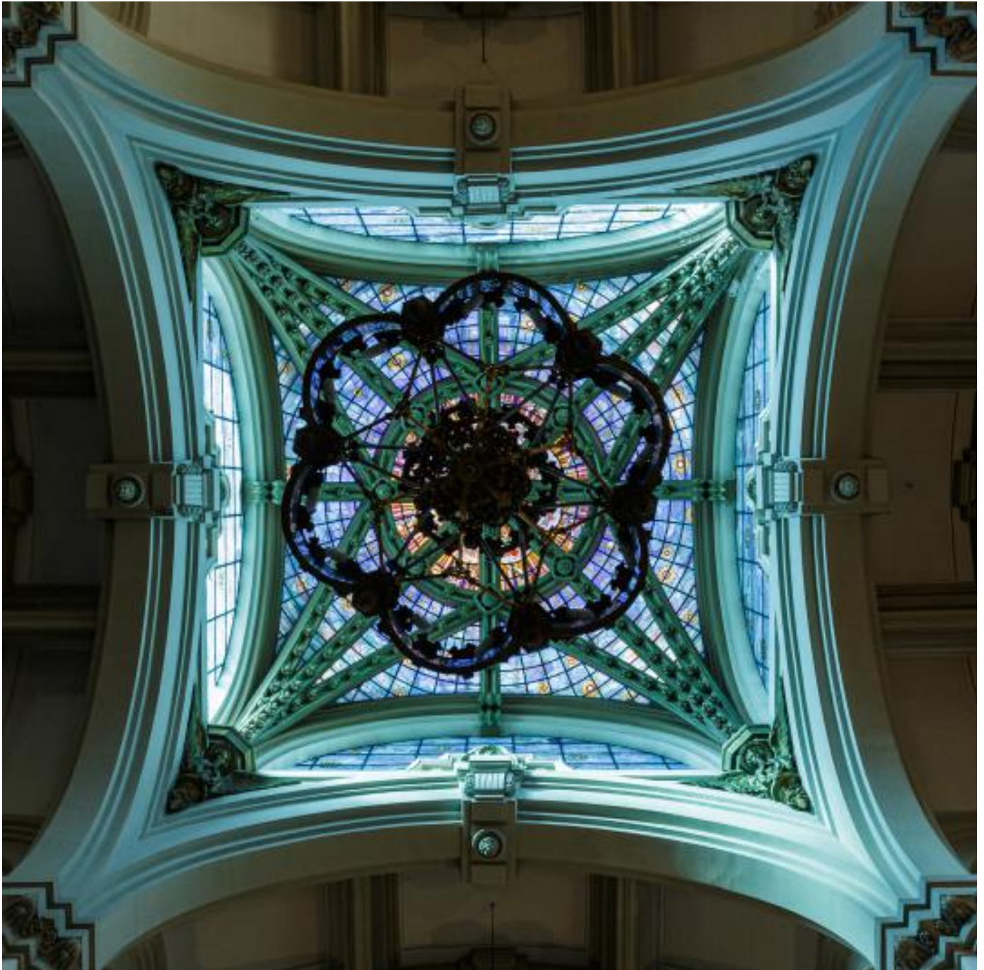
Foto 8: Vista de la cúpula nervada de plementos acristalados que culmina el cimborrio.
