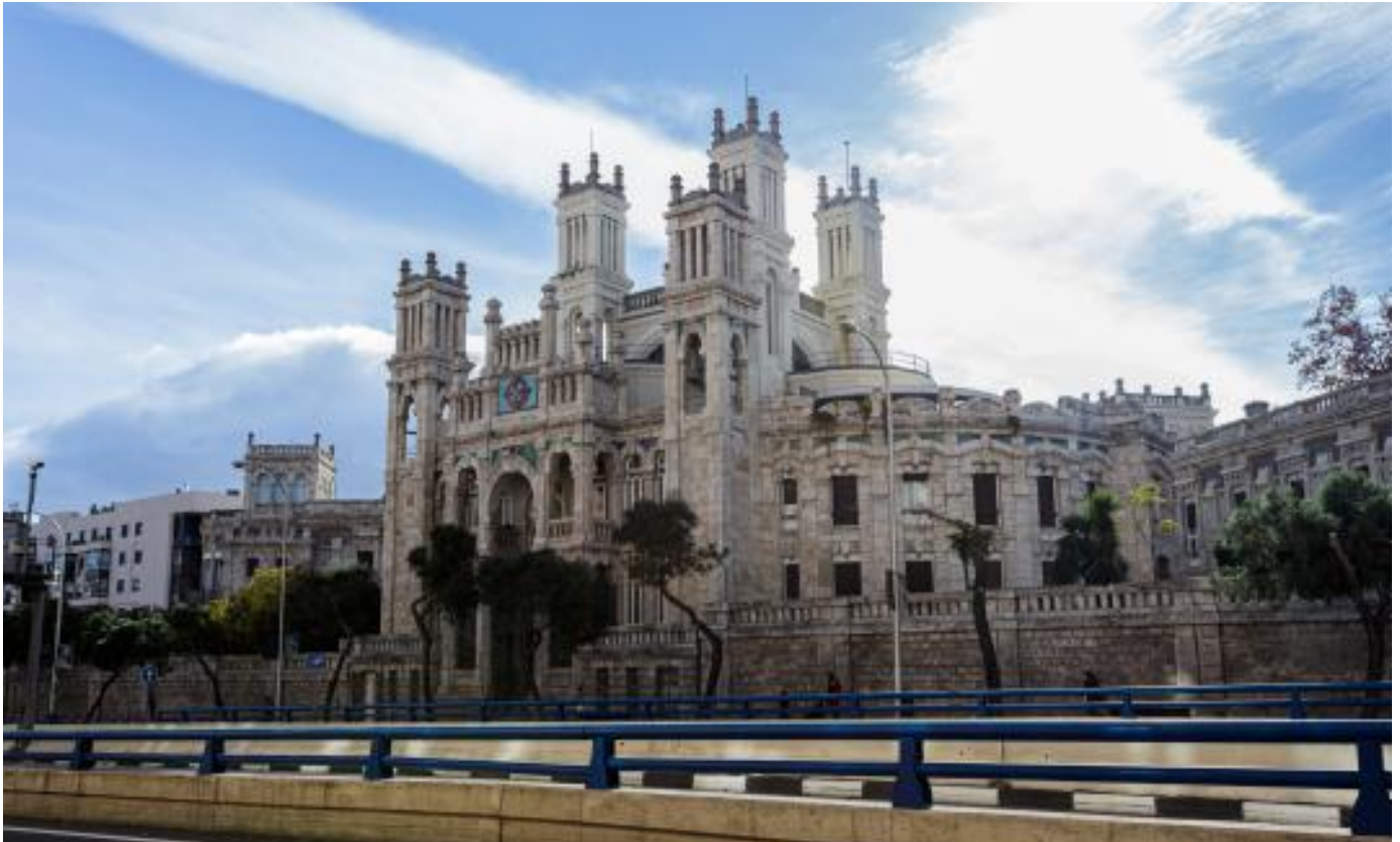
Foto 3: Vista general de la fachada principal del antiguo hospital de Maudes en el que destaca decididamente el perfil de su templo.
