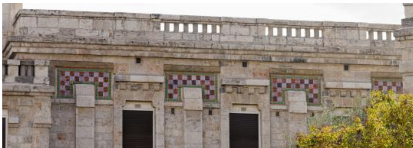
Foto 5: Decoración en azulejería de “gota de agua”, en disposición ajedrezada.
