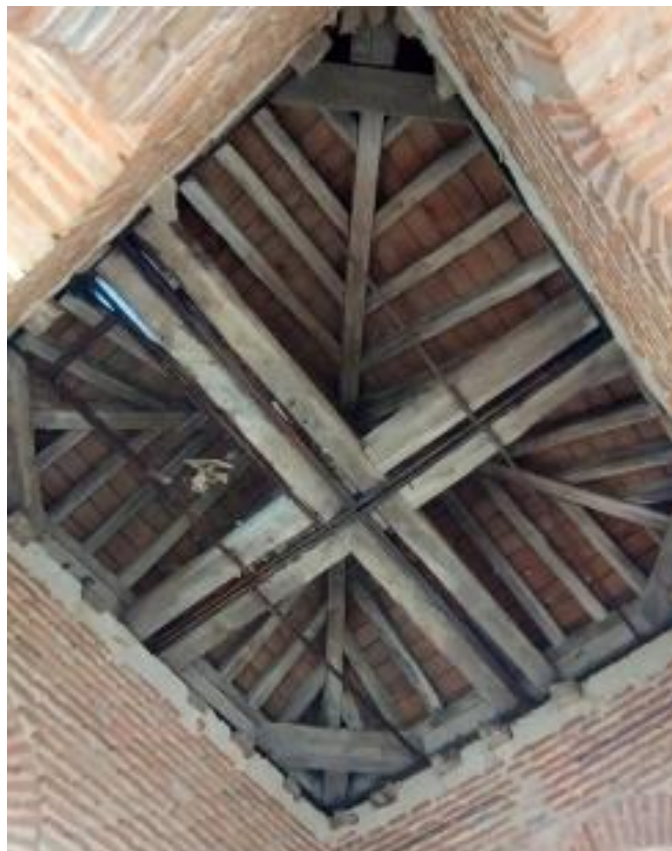
Foto 37: Armadura de cubierta de la torre (Foto: José Manuel Castellanos).
