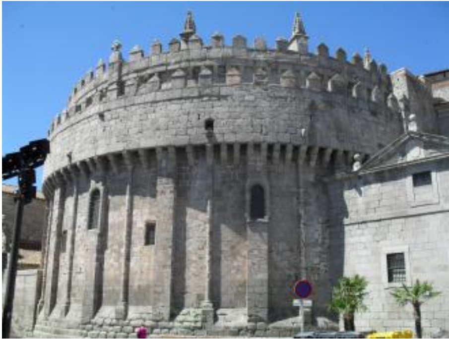
Foto 13: "Cimorro" de la Catedral de Ávila. Potente ábside románico del templo, edificado en sillar, que se integra en el recinto amurallado abulense y aparece rematado por doble paso de ronda rematado por merlones (Fuente: www.castillosdeespaña.es ).
