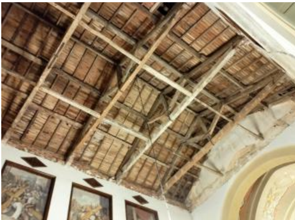
Foto 25: Vista general de la armadura reconstruida con elementos del siglo XV, y parte del arco triunfal del ábside mayor, donde se aprecia la ojiva que remataba el arco apuntado original del siglo XIII (Foto: José Manuel Castellanos Oñate).
