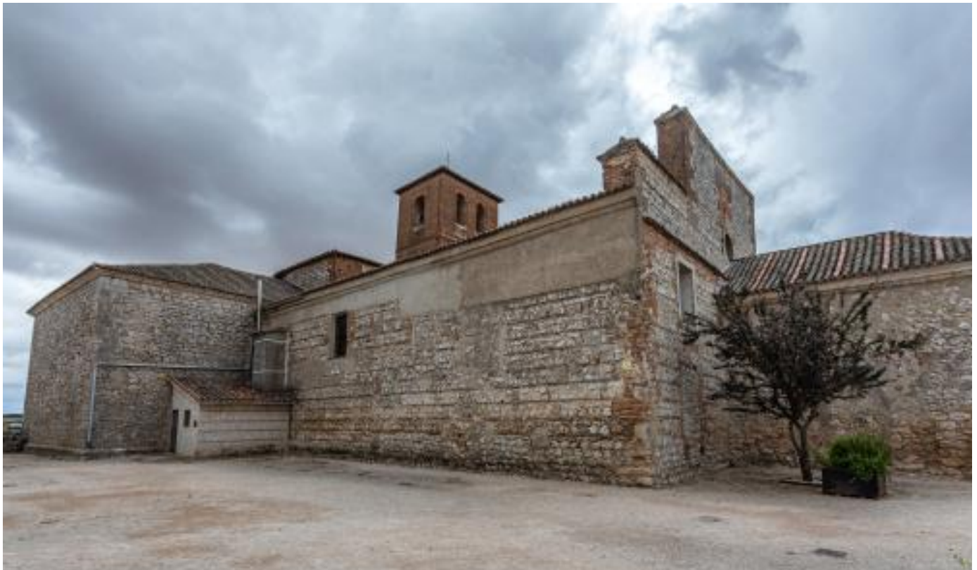
Foto 15: Vista general del templo por el noroeste.
