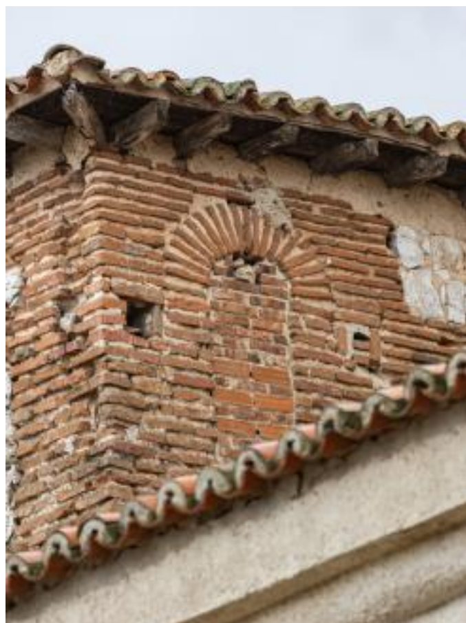
Foto 16: Pequeña puerta mudéjar de arco de herradura que permitía el acceso al paso de ronda del ábside mayor y de la muralla.
