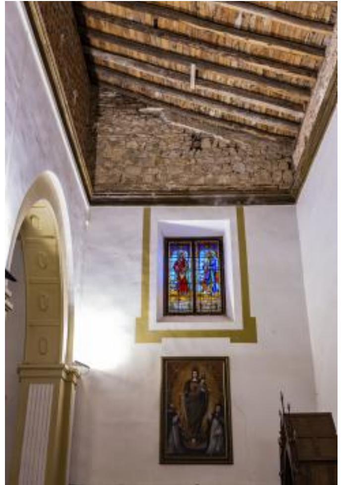
Foto 20: Pies de la nave del evangelio con las vidrieras de los evangelistas San Juan y San Lucas , y pintura de la Virgen del Rosario .
